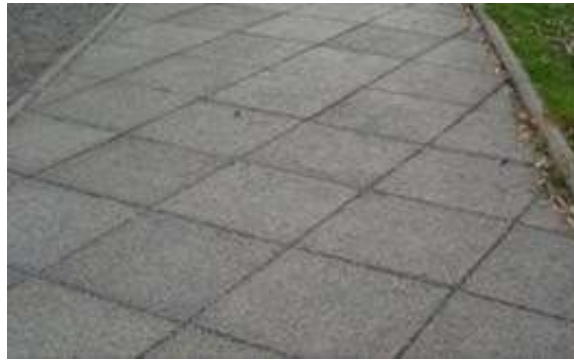
Figura 8– Calçada composta por revestimento permeável de placas de concreto.
