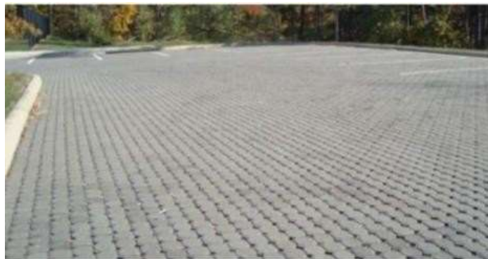
Figura 4 – Estacionamento constituído com revestimento de peças com áreas vazadas.
