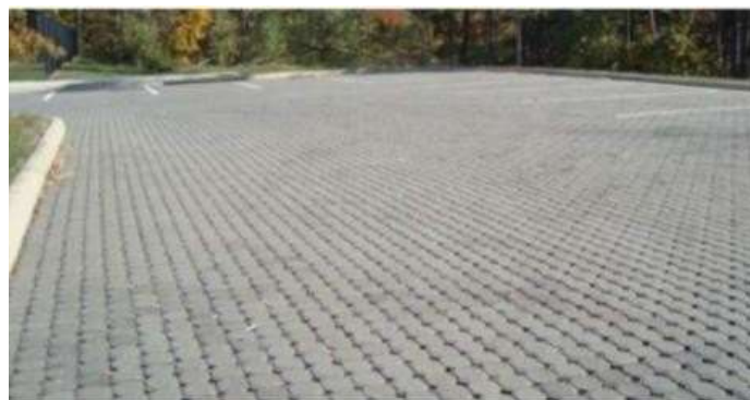
Figura 7 – Execução do revestimento em grade.
