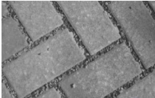
Figura 2 – Pavimento revestido com peças de concreto com juntas alargadas.
