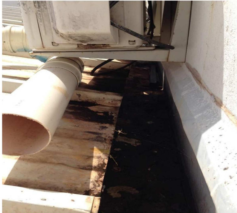
Figura 11 - Vista de calhas instaladas
