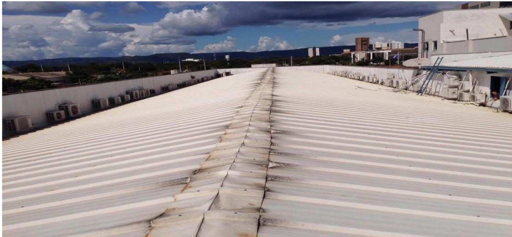
Figura 9 - Telhado do Centro Oncológico de Palmas
