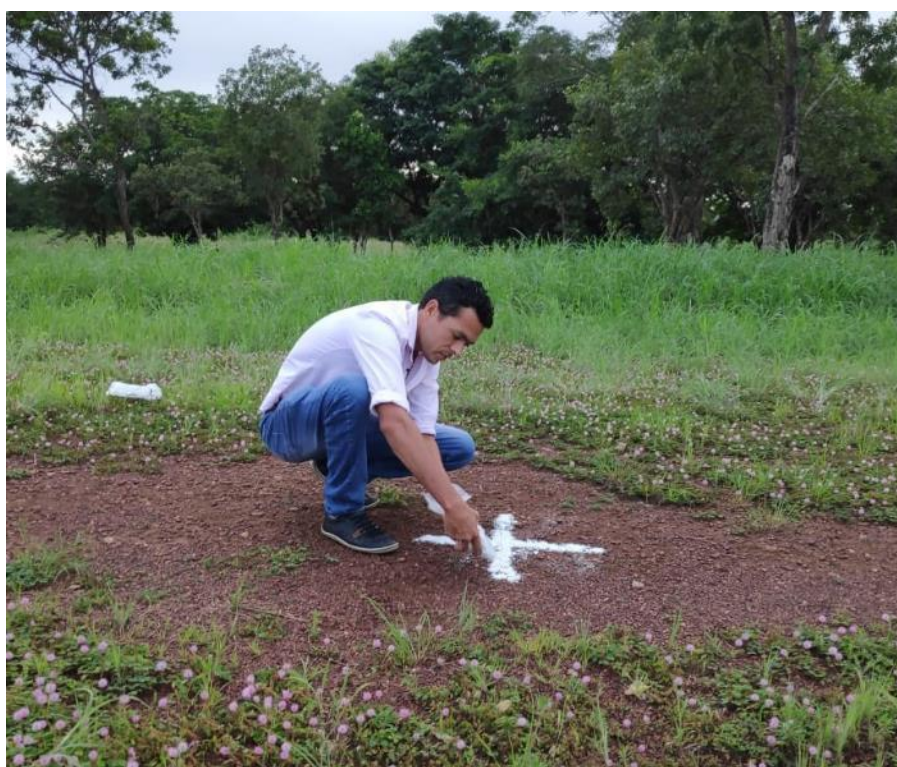
Figura 23 - Marcação dos pontos de controle com Cal
