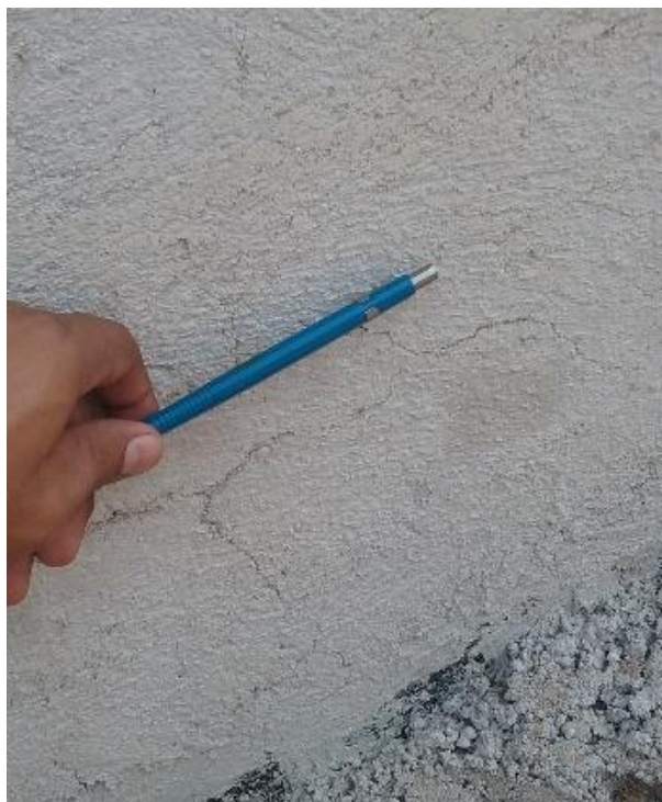
Figura 22 - Apresentação de fissura
