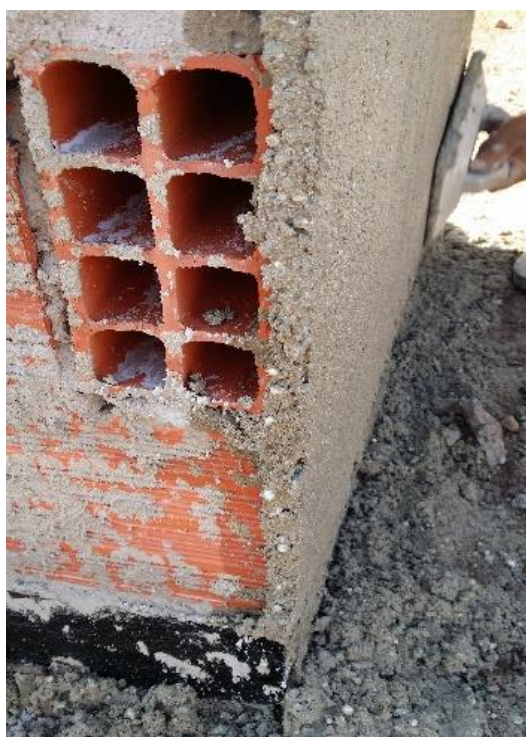
Figura 13 - Argamassa sendo regularizada com a desempenadeira
