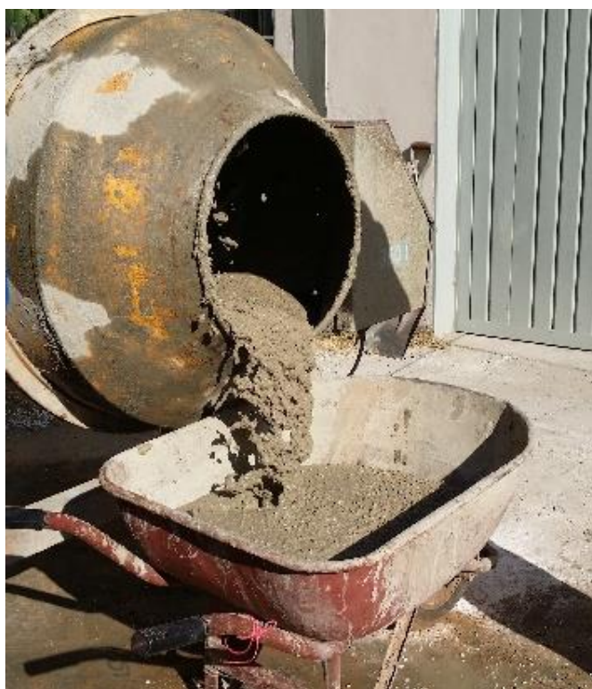
Figura 14 - Projeção da argamassa no carro de mão
