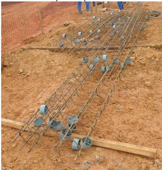
Figura 13- Armaduras das estacas prontas para serem inseridas.
