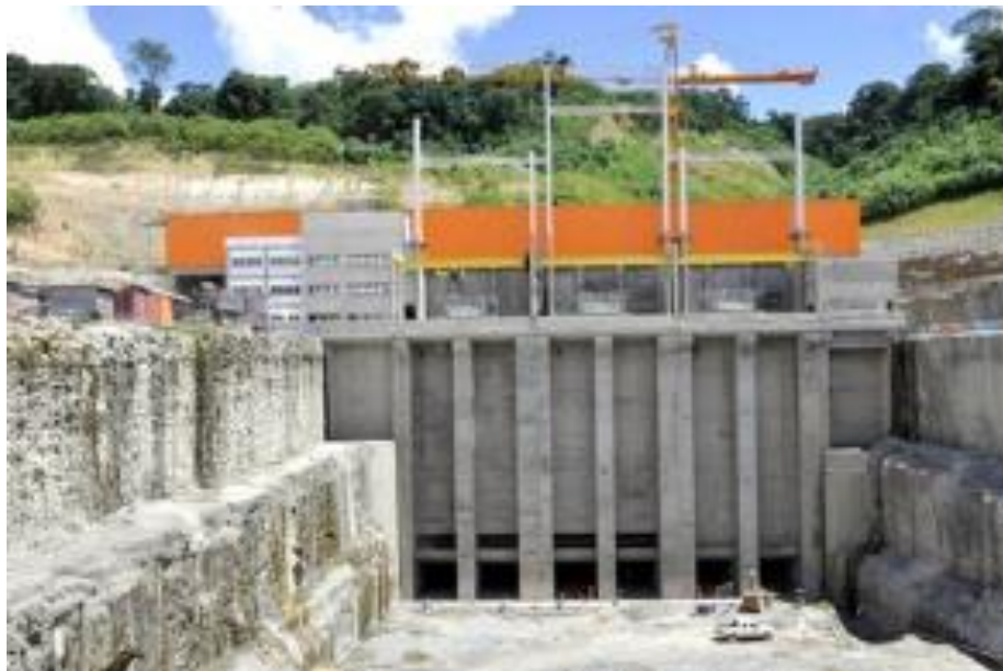
Figura 10 - Vista do Canal de Fuga em construção da Usina Mauá
