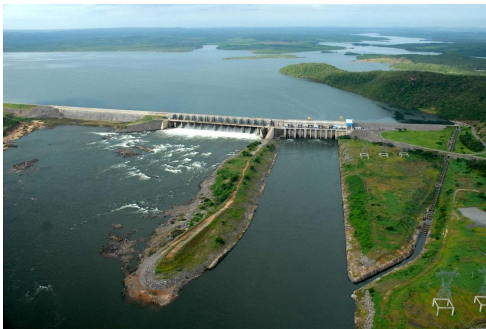
Figura 12 - Vista aérea da UHE da cidade de Lajeado – Canal de fuga à direita após turbinas
