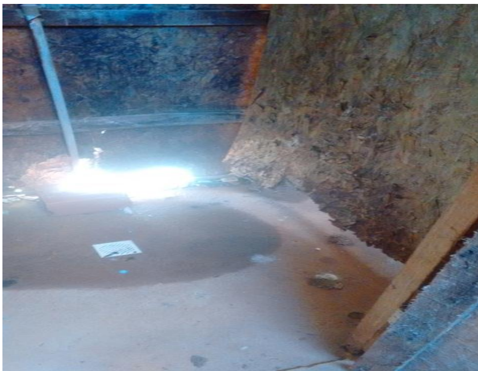
Figura 12. Apodrecimento chapa de madeira Amostra 1.
