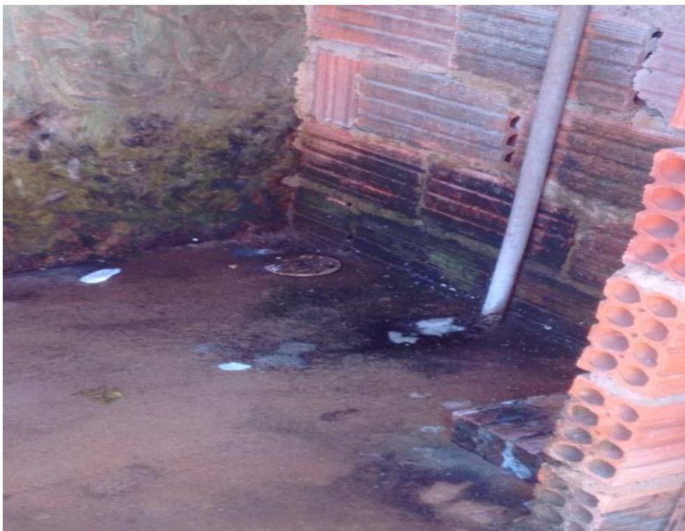
Figura 20. Lodo nos compartimentos do Chuveiros
