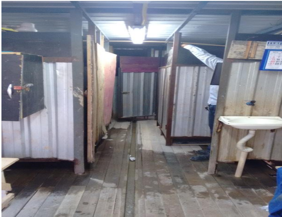
Figura 18. Instalações Sanitárias Amostra 6
