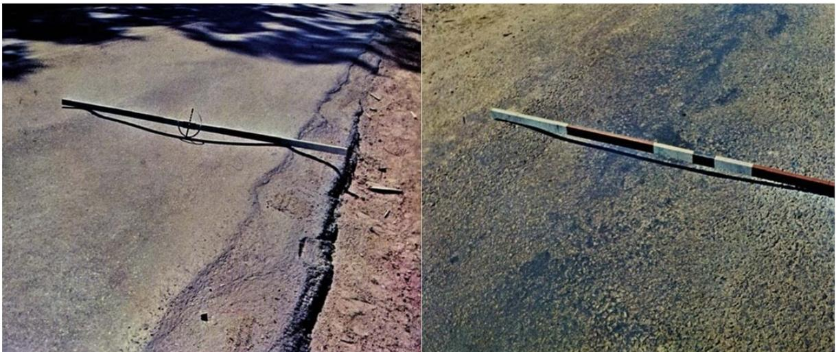
Foto 05: afundamento de trilha de roda
