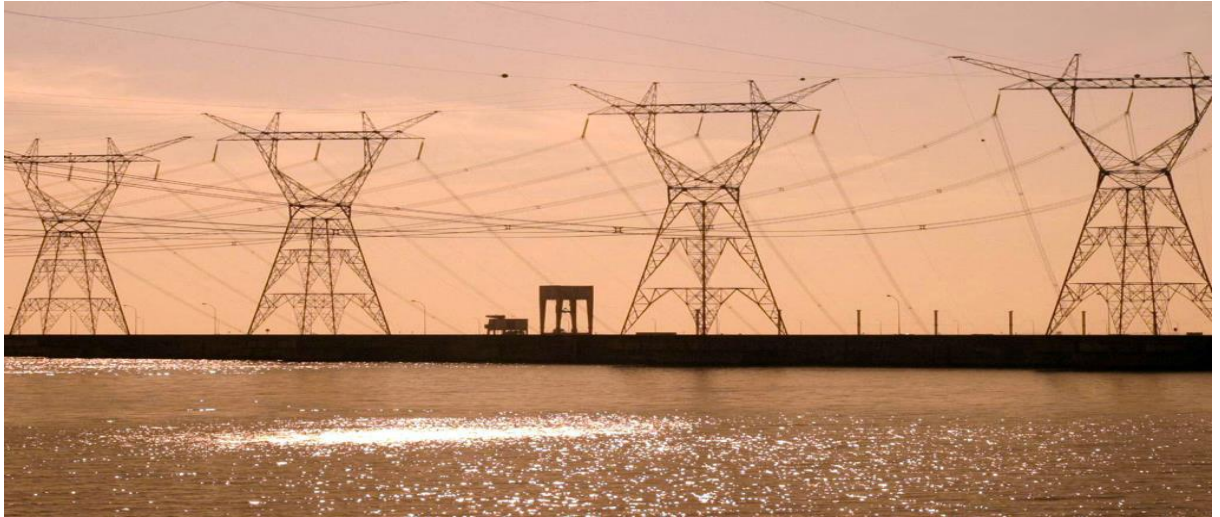
Foto 02 – Linhas de transmissão de energia elétrica. Fonte: site, GOOGLE 2014.
