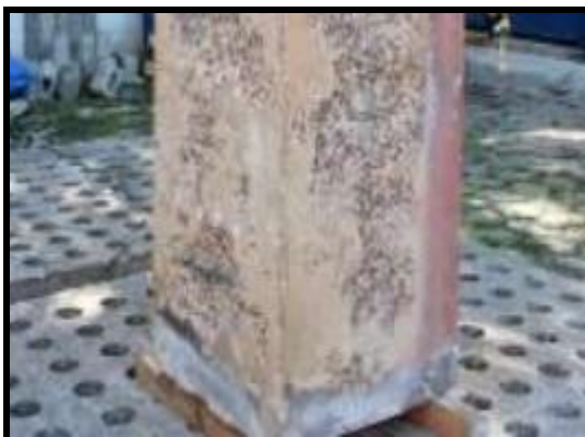
FIGURA 8 - Ação do fogo em estruturas de concreto. Fonte: Chociay (2015).
