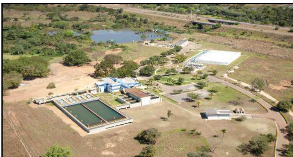
FIGURA 15 - Vista aérea da estação de tratamento do sistema produtor Taquaruçu (ETA – 006). Fonte: Prefeitura de Palmas, 2015.
