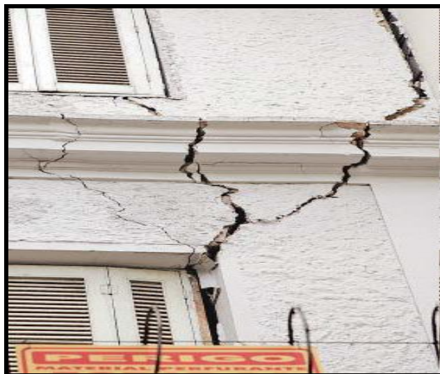
FIGURA 7 – Efeito da atuação de sobrecargas em estruturas de concreto. Fonte: Werle (2011).
