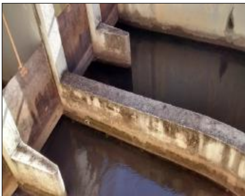
FIGURA 18 - Gradeamento da estação com sinais de erosão em canal. Fonte: Autoria Própria (2015).
