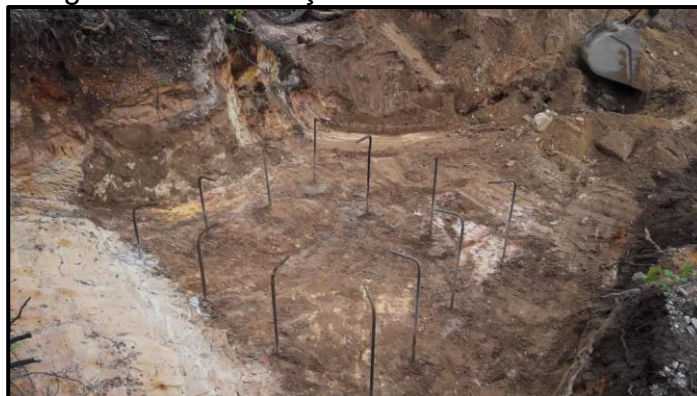
Figura - 5 - Fundação ancorada em rocha
