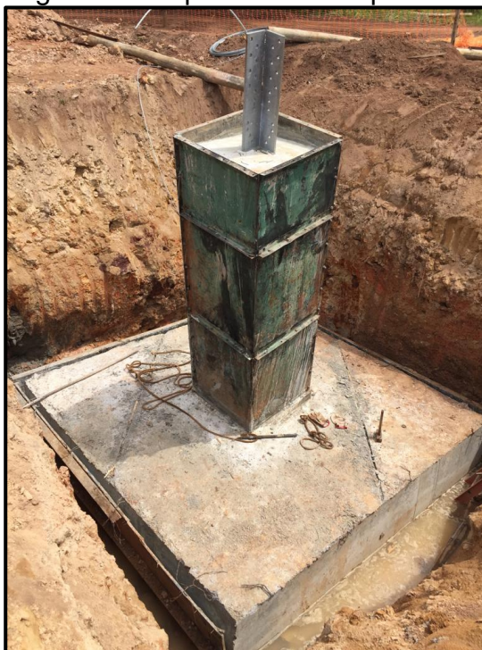
Figura - 3 Sapata em solo tipo 1G
