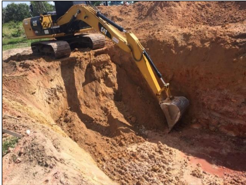
Figura - 24 - Escavação em solos argilosos
