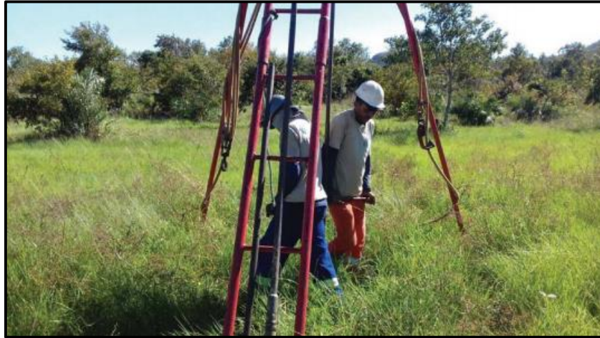
Figura - 23 - Sondagem a trado em solo fraco torre 67
