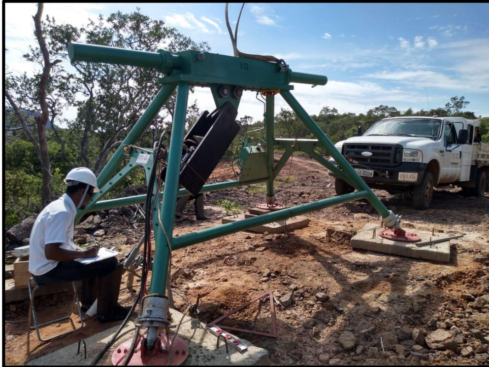
Figura - 10 - Execução de ensaio de arrancamento do solo
