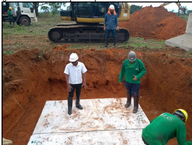
Figura - 40 - Colocação de placas em solos fraco tipo I
