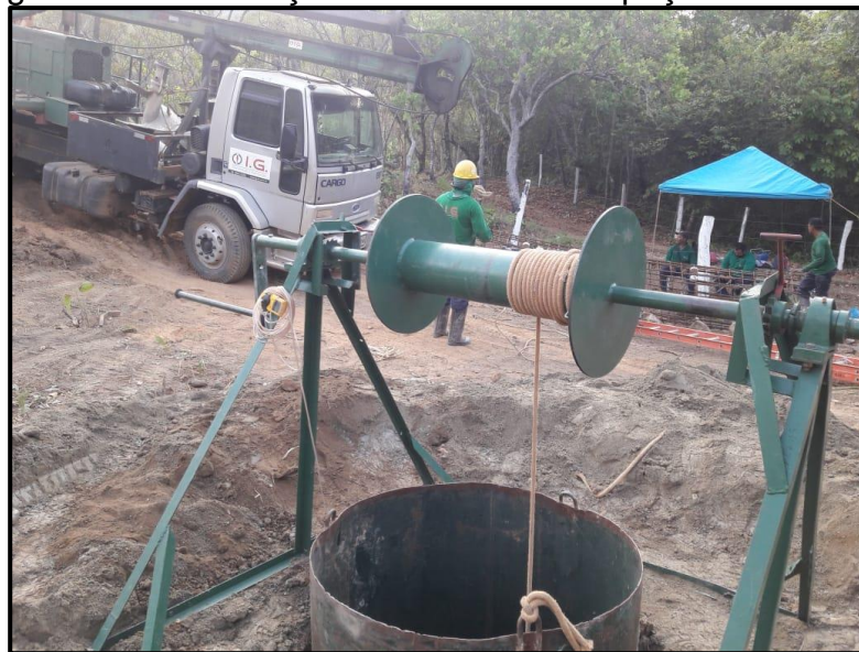
Figura - 6 - Escavação de tubulão em espaço confinado
