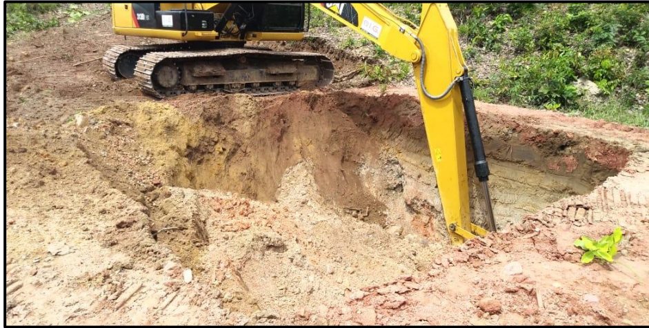
Figura - 25 -Escavação em solos siltosos
