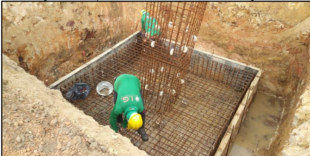
Figura - 2 - Sapata executada em solo com nível d'água.
