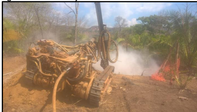
Figura - 4 Perfuração em rocha com Rock Drill
