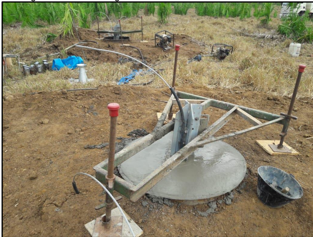
Figura - 7 - Concretagem e alinhamento de stub em tubulão.
