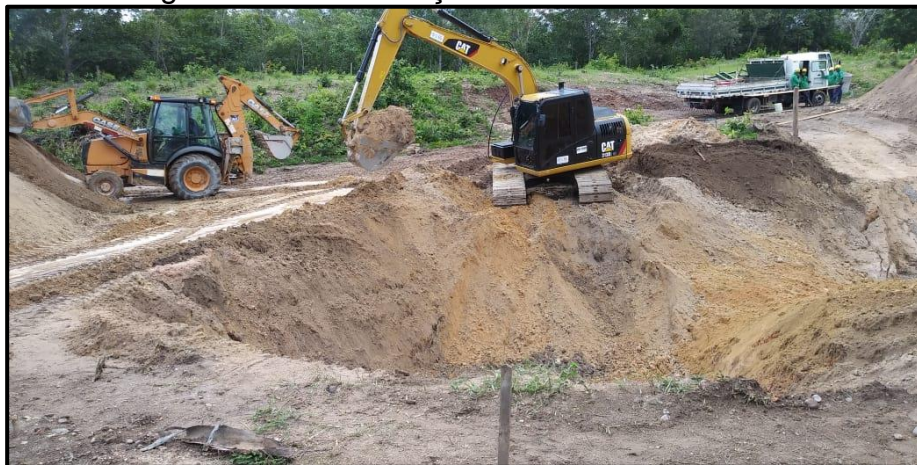
Figura - 26 - Escavação em solos arenosos
