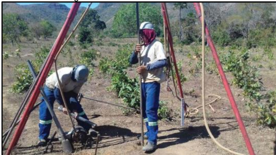
Figura - 21 - Ensaio SPT torre 87
