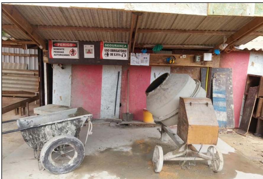
Figura 11 - Betoneira no qual é realizada a dosagem da massa única
