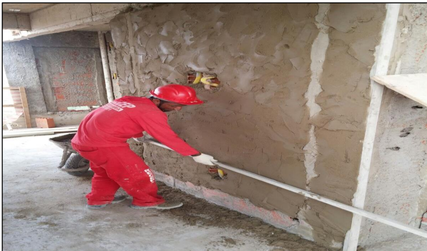
Figura 13 - Colaborador executando serviço de sarrafear
