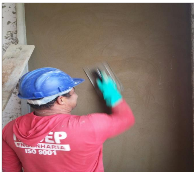
Figura 15 - Colaborador executando serviço de desempenar
