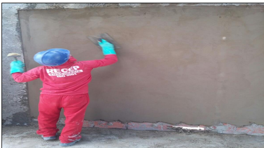
Figura 14 - Colaborador executando serviço de desempenar
