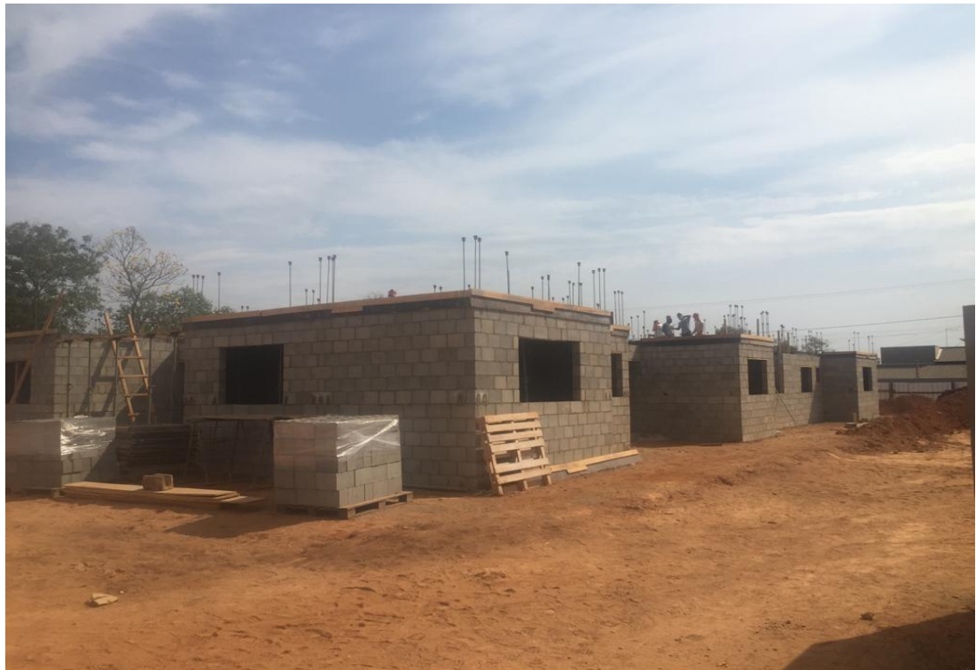
Figura 3: Construção de residencial em Palmas/TO.
