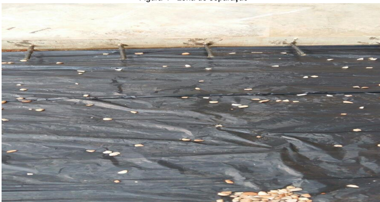
Figura 4 - Lona de separação
