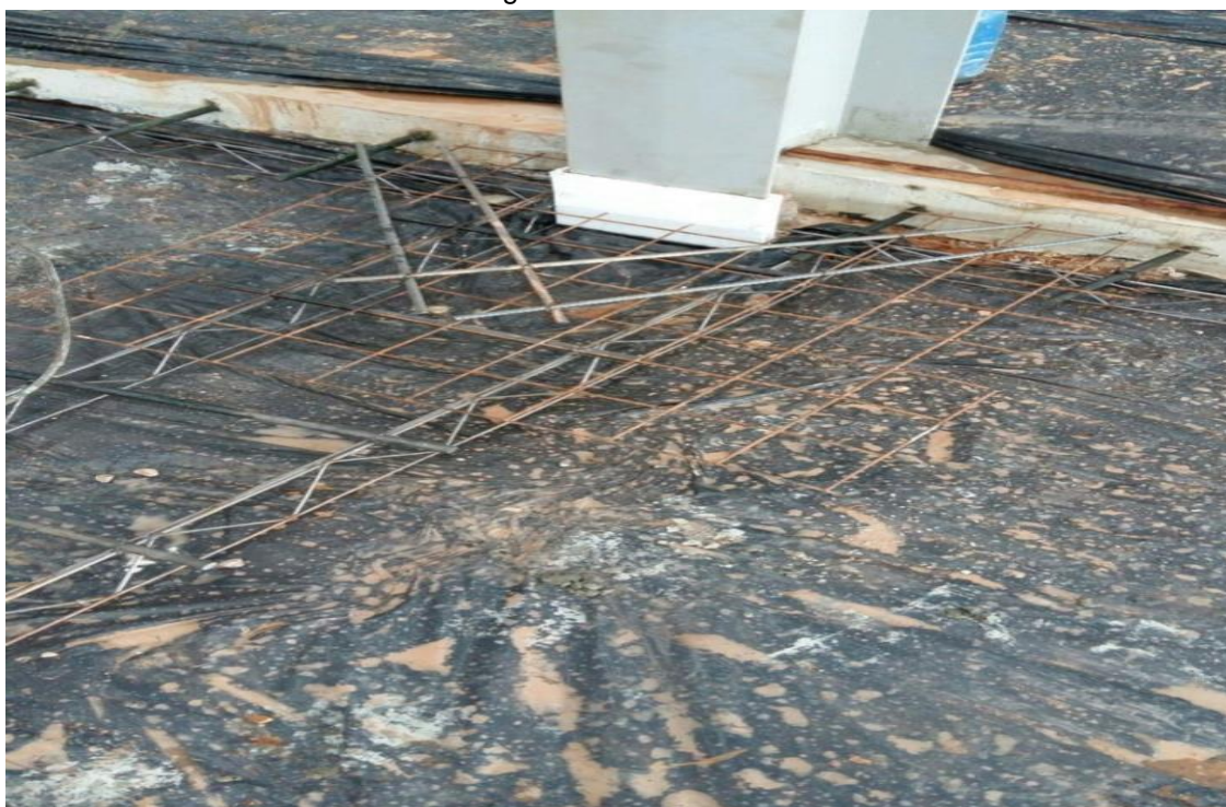
Figura 6 - Armaduras
