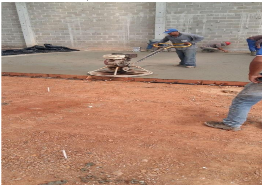
Figura 8 - Acabamento do Piso
