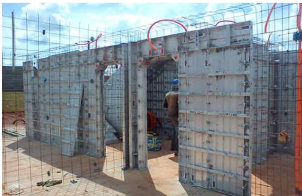
Figura 11 – posicionamento e fixação das formas metálicas
