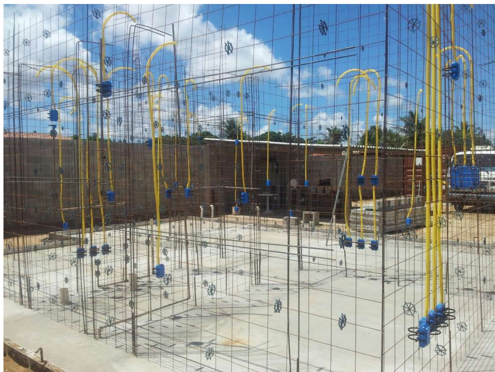
Figura 10 - montagem da ferragem e eletrodutos
