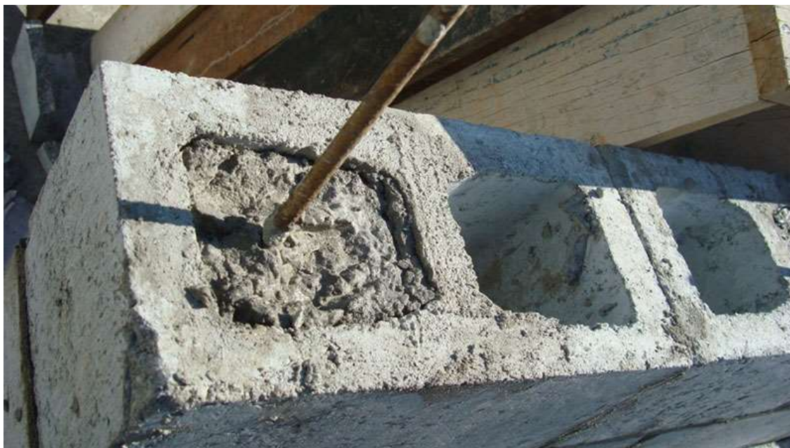
Figura 26 – Grout executado
