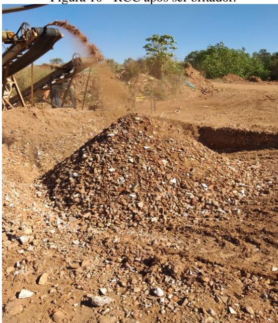
Figura 10 - RCC após ser britador.
