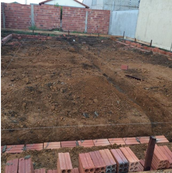
FOTO 01 – Locação de obra
