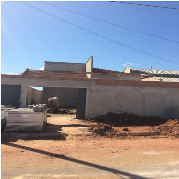
FOTO 07 – Estrutura madeira telhado
