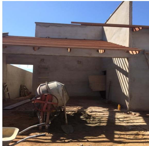
FOTO 08 – Estrutura madeira telhado
