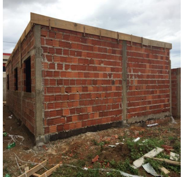
FOTO 06 – Alvenaria de vedação
