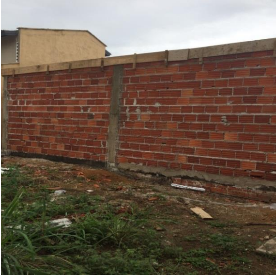
FOTO 05 – Alvenaria de vedação
