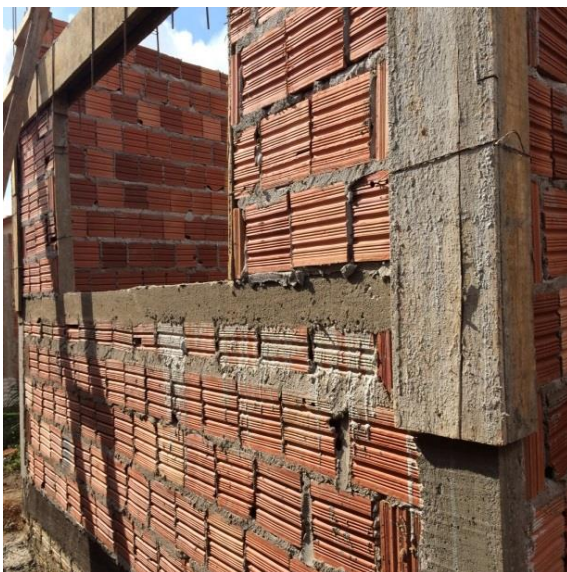
FOTO 03 – Pilares e vigas
