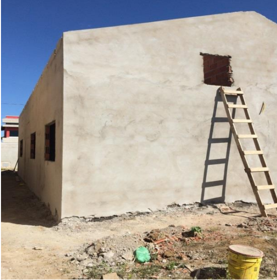
FOTO 9 – Reboco externo
