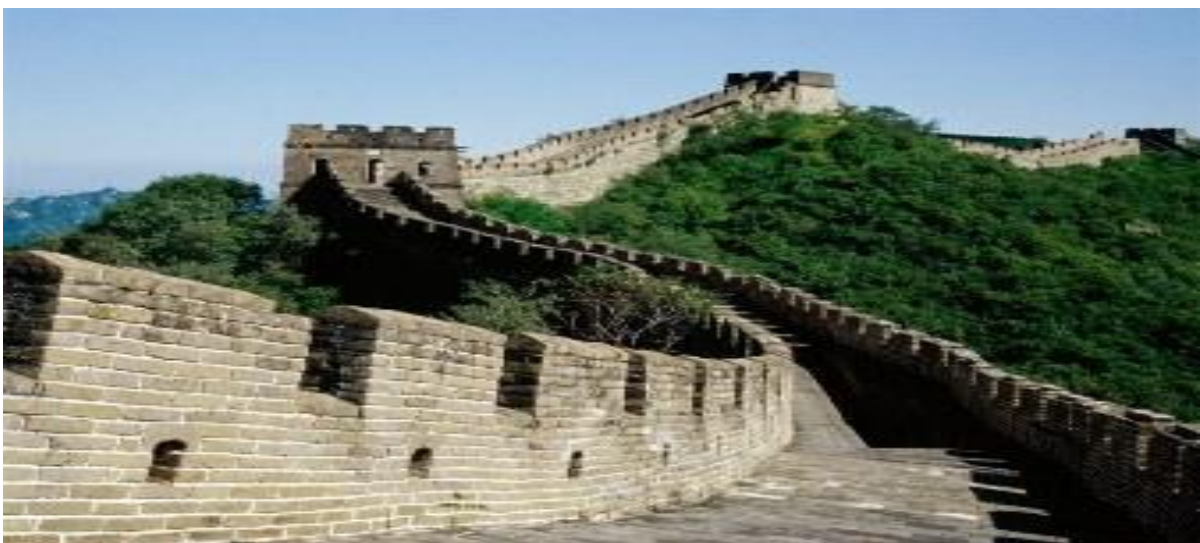
Figura 2: Muralha da China
