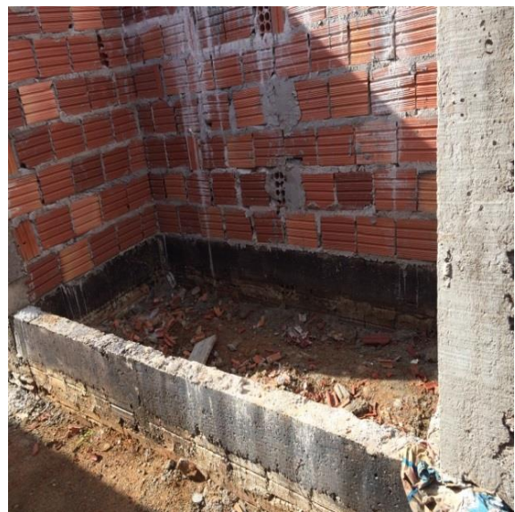
FOTO 04 – Pilares e vigas
