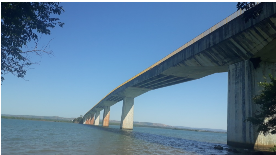
Figura 8 - Vista da Ponte de Porto Nacional
