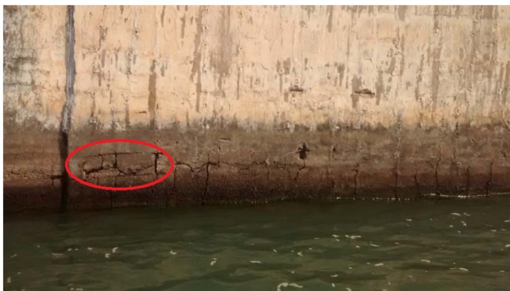
Figura 14 - Fachada montante do pilar P6 em 2016
