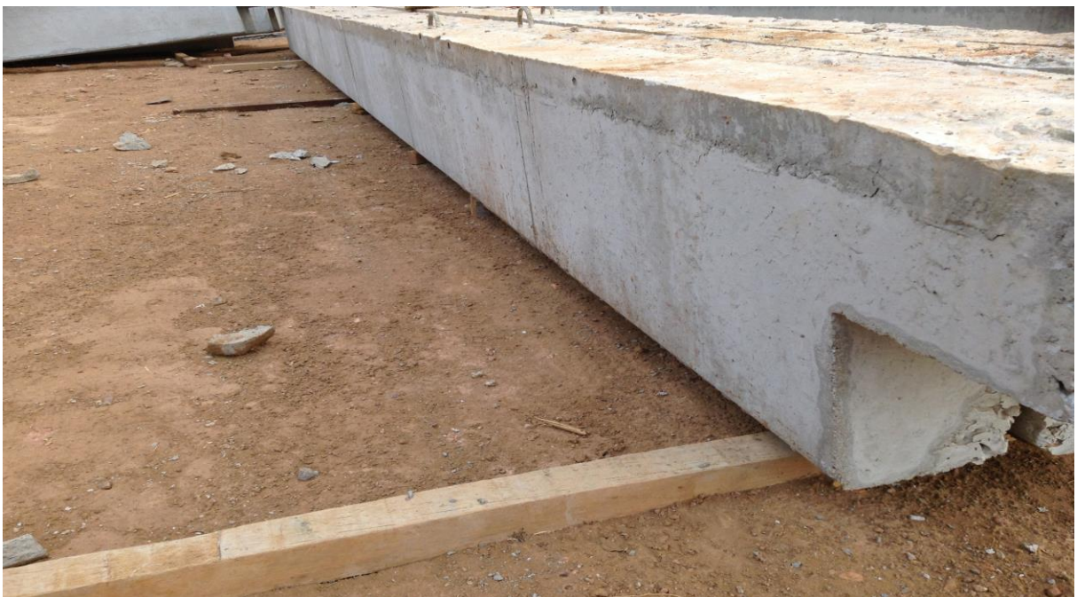
Figura 36: Montagem das vigas, estoque na obra.
