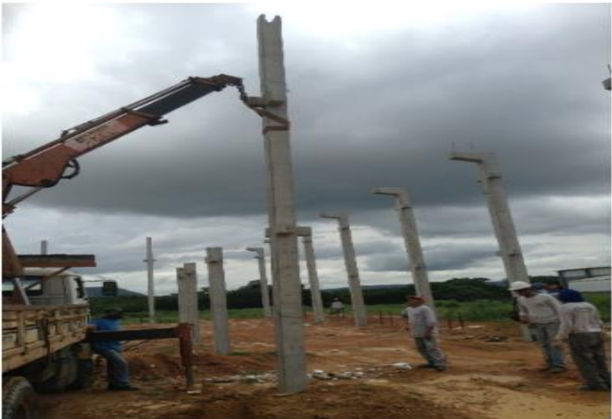
Figura 41: Suspendendo pilar com alça de içamento.
