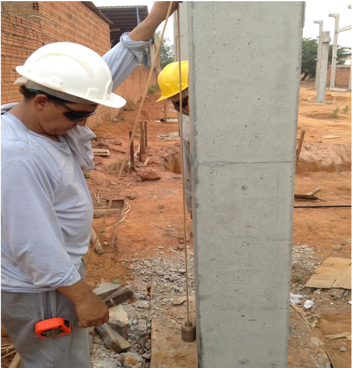
Figura 34: Montagem dos pilares, conferindo prumo.
