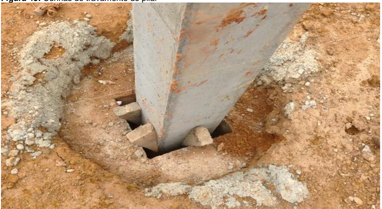
Figura 43: Cunhas de travamento do pilar
