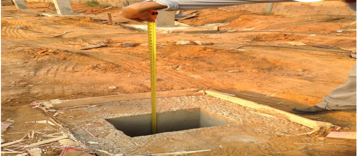
Figura 32: Conferência das fundações.
