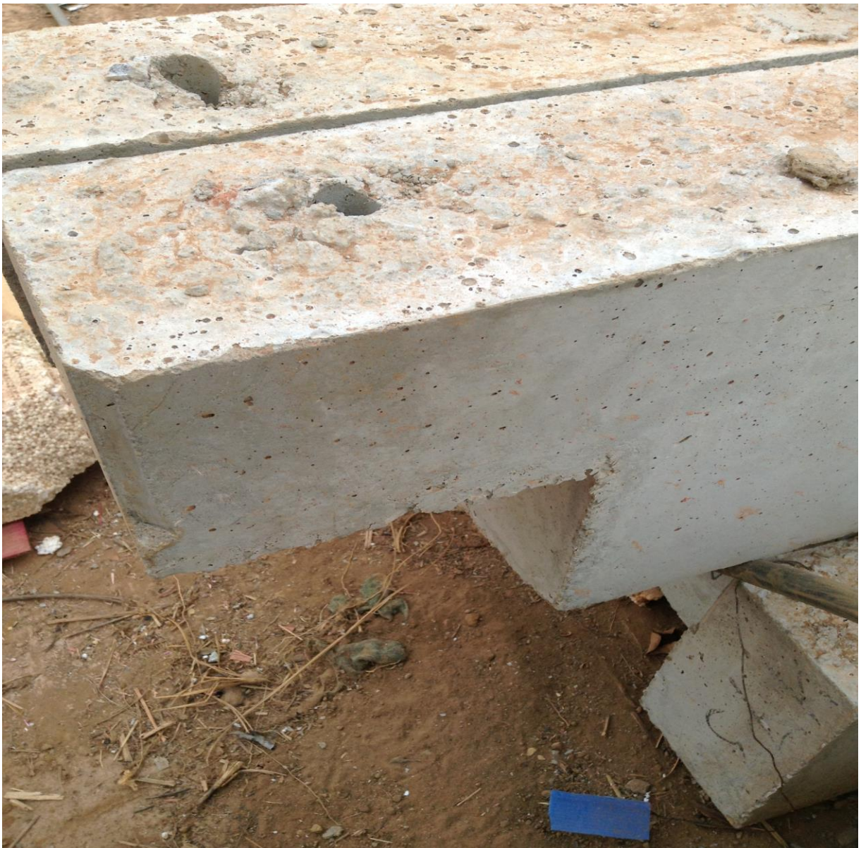
Figura 37: Limpeza dos consoles de apoio e furos dos pinos de travamento.
