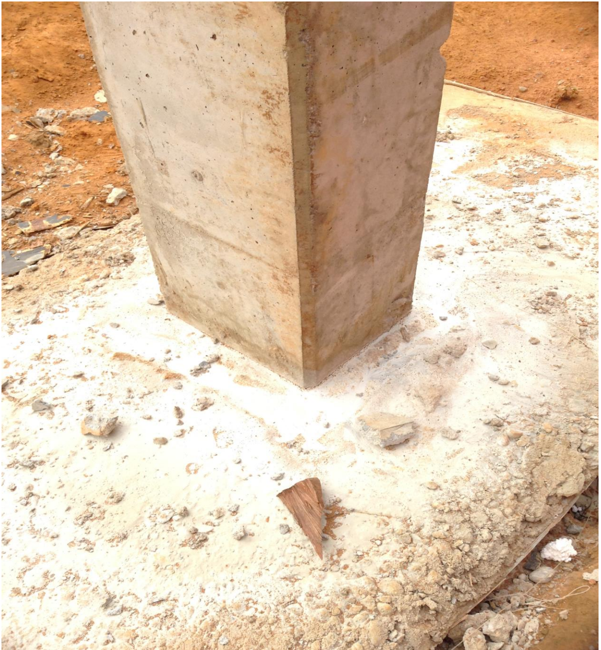
Figura 35: Fixação dos pilares.
