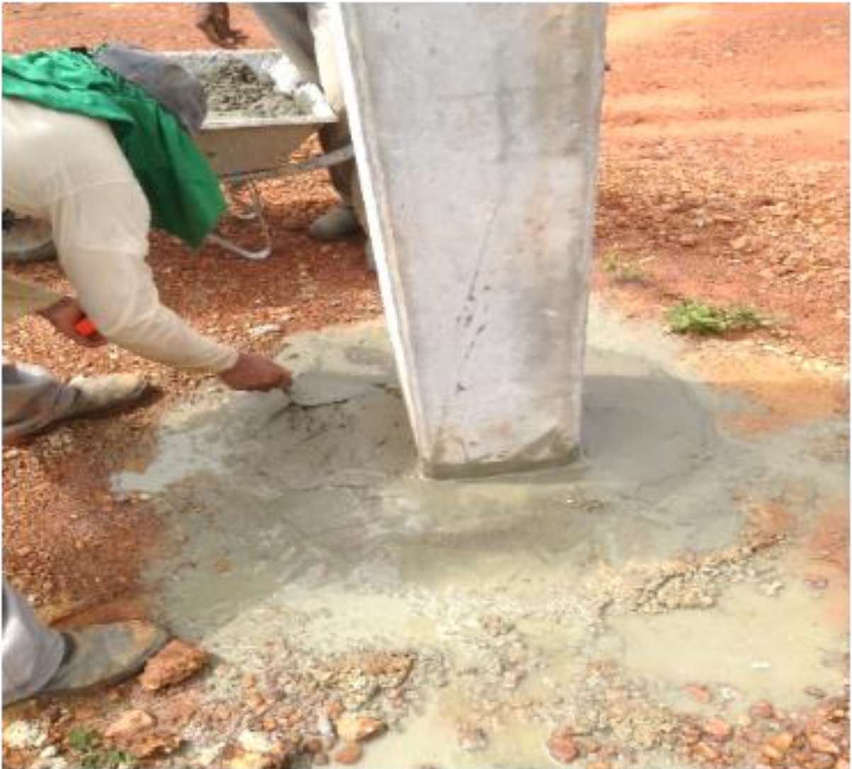
Figura 44: Concretando Pilar após retira das cunhas de madeira.
