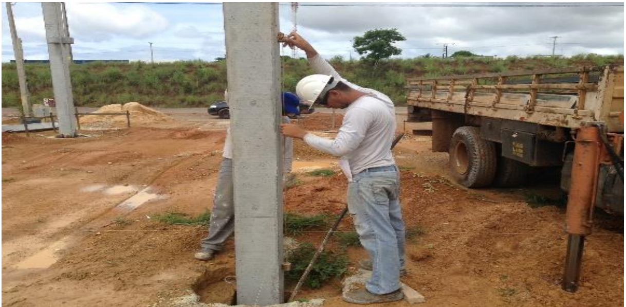
Figura 42: Conferindo prumo do pilar.
