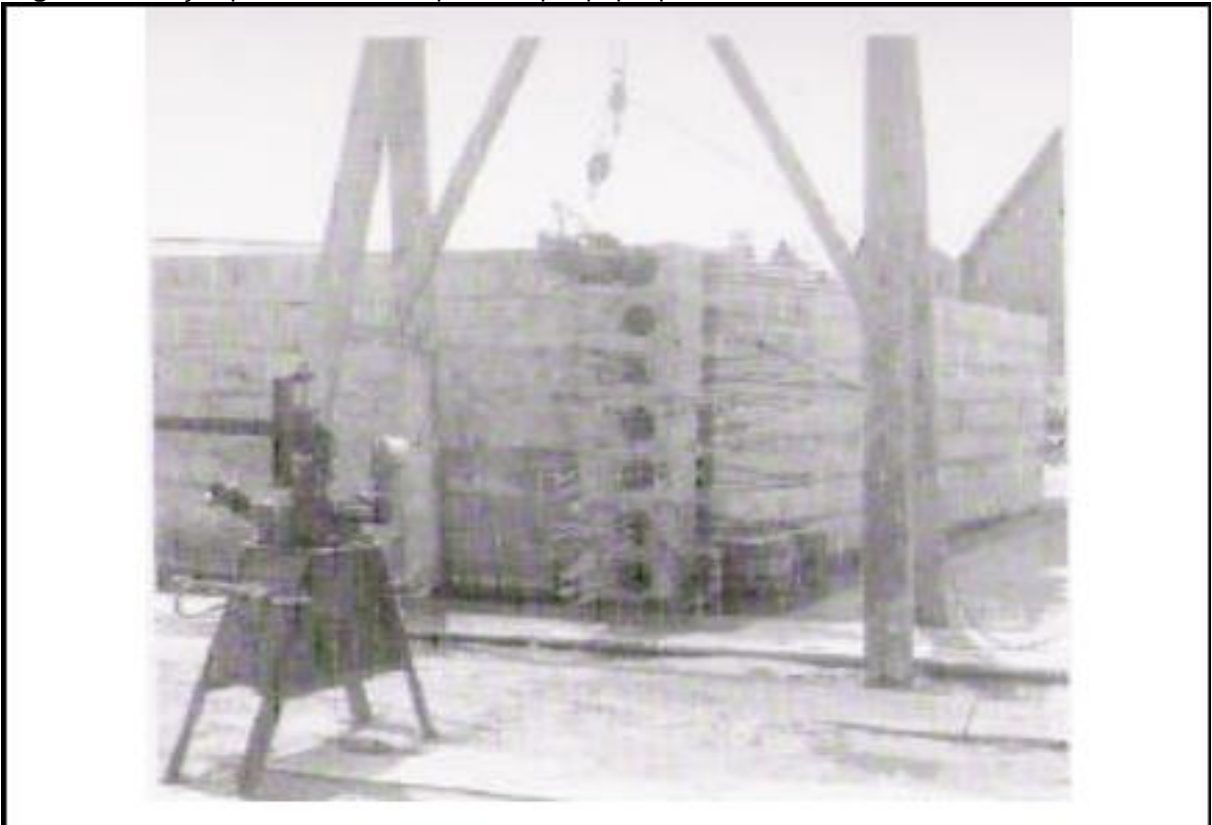
Figura 2 – Peças pré-fabricadas separadas por papel parafinado
