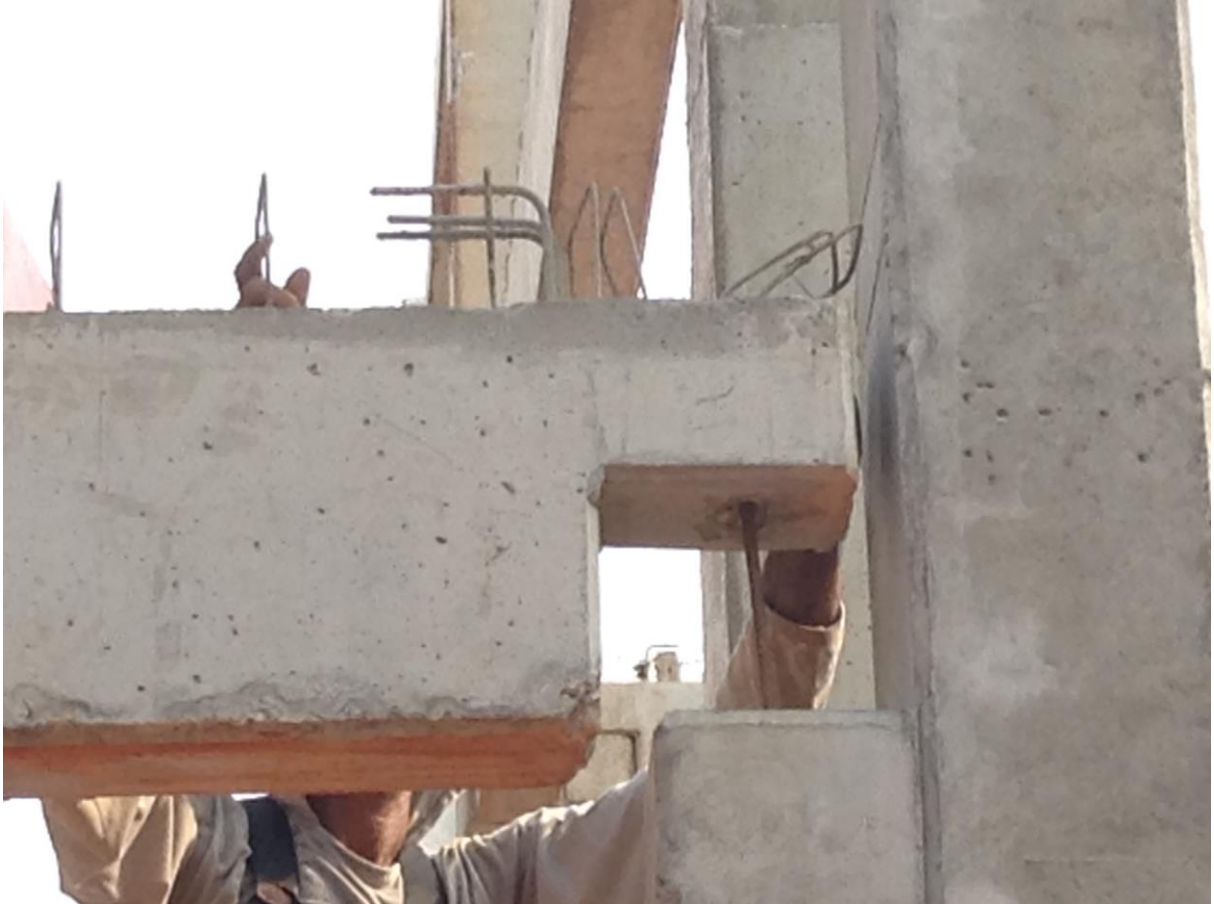
Figura 39: Ligação das peças com pinos de travamento.
