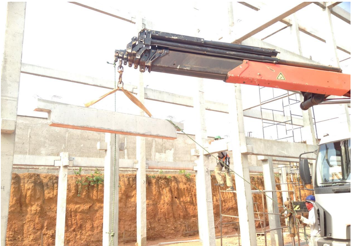
Figura 38: Içamento das vigas.
