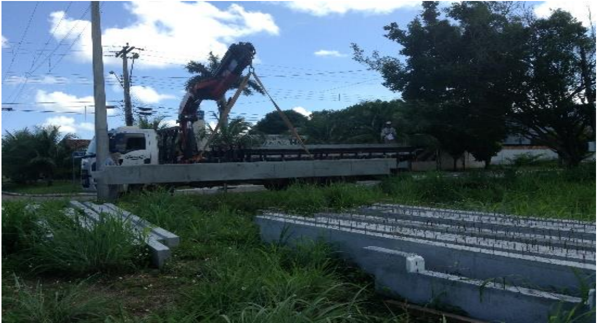
Figura 46: Estoque na obra.
