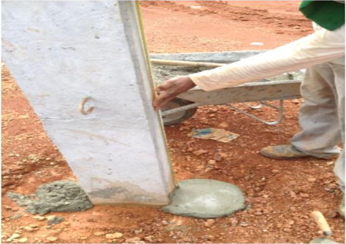
Figura 45: Conferindo nível do consolo com nível da obra.
