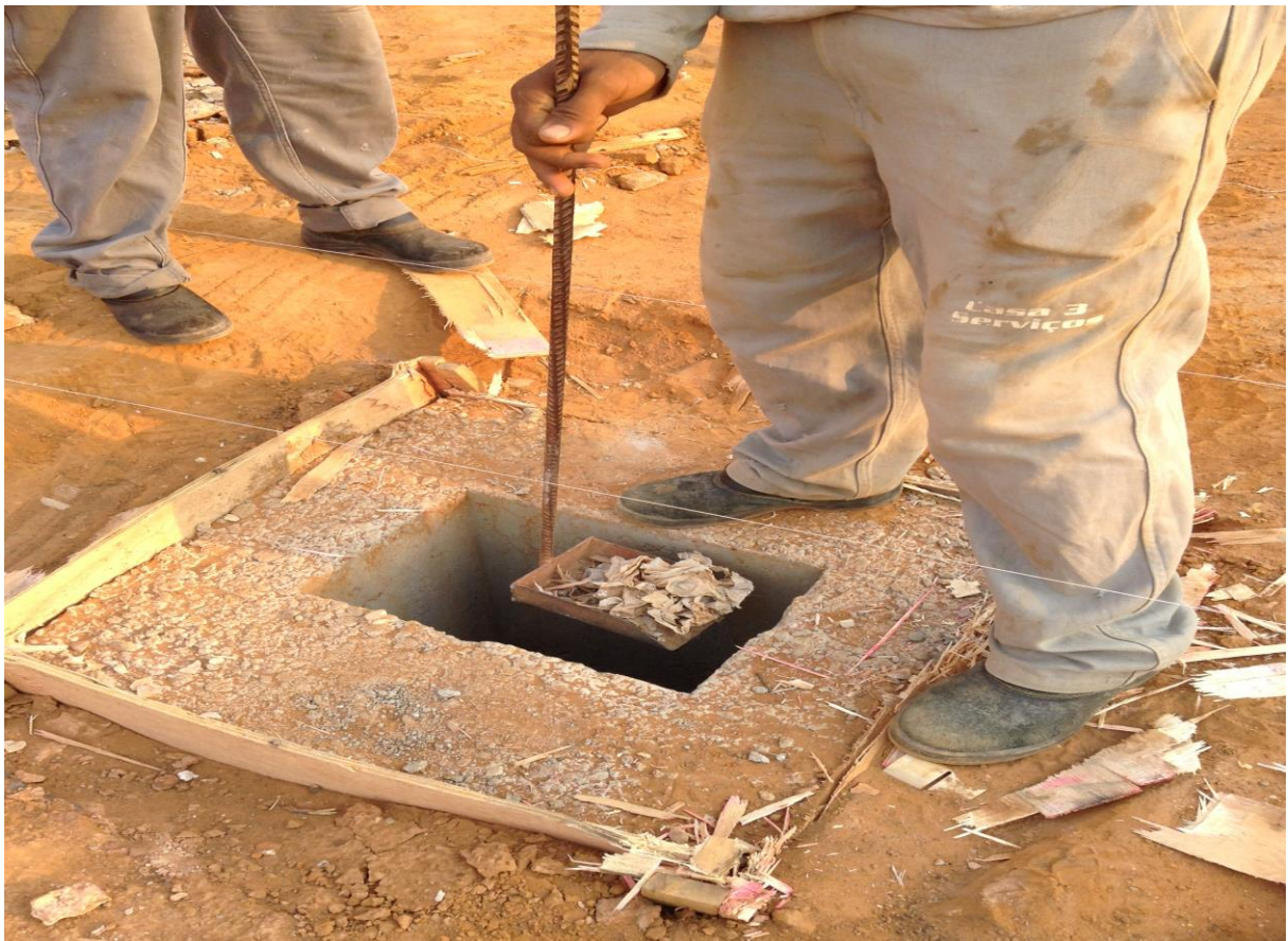
Figura 40: Limpeza dos fundos dos cálices de encaixe nas fundações.
