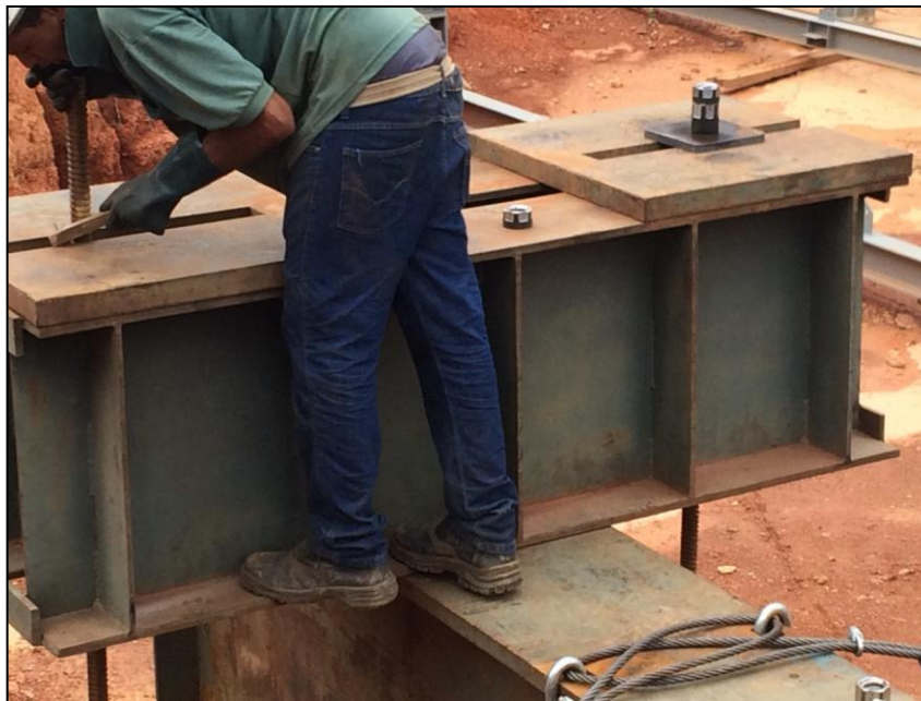
Figura 19 - Aplicação e Travamento da Viga Secundária Fonte: Do autor, 2015
