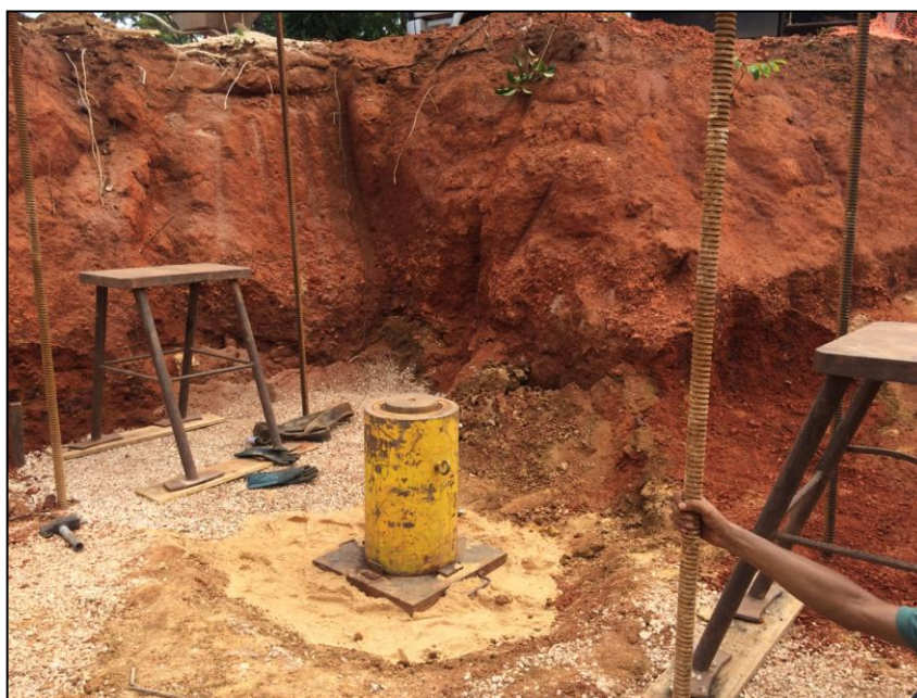
Figura 17 - Tirantes e Macaco Hidráulico Fonte: Do autor, 2015
