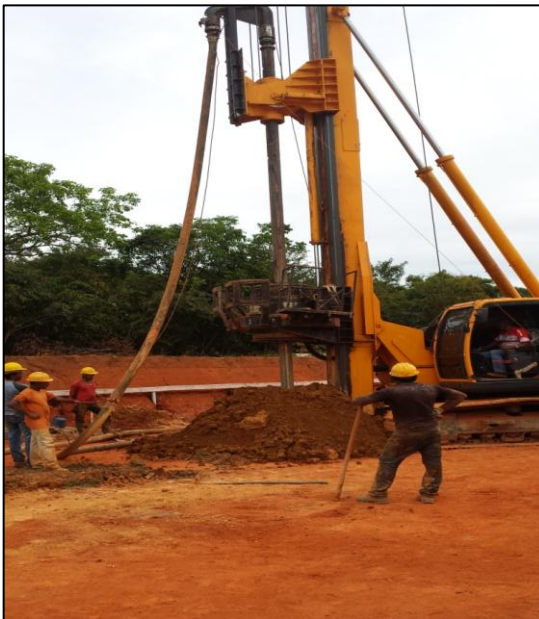
Figura 12 - Perfuração de Estaca Fonte: Do autor, 2015
