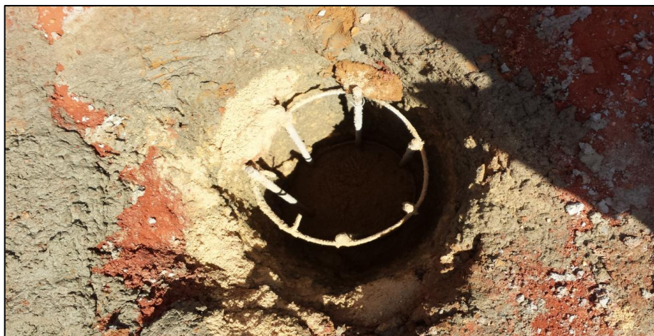
Figura 13 - Aplicação de Armadura Fonte: Do autor, 2015
