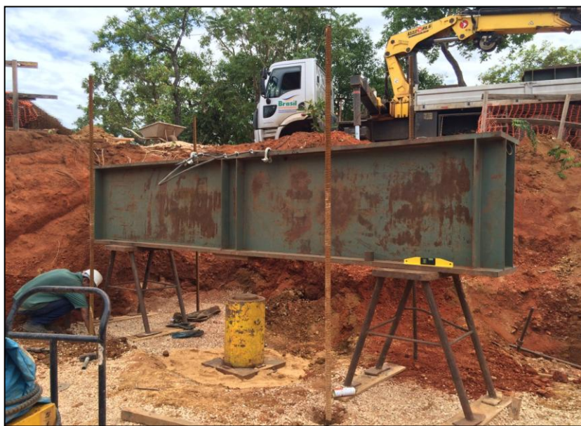
Figura 18 - Aplicação da Viga Primária Fonte: Do autor, 2015
