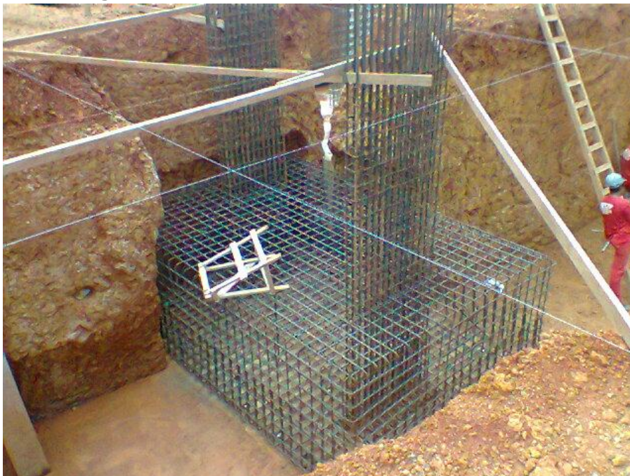
Figura 24 – Bloco S5/8 do projeto sendo executado.
