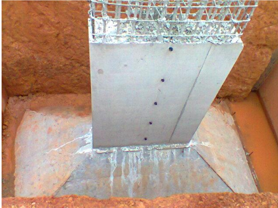
Figura 25 – Sapata S12 do projeto executado.
