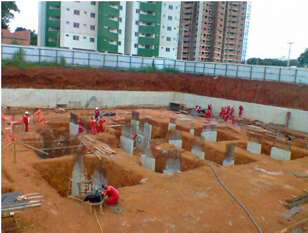
Figura 26 – Fundação do projeto sendo executada.
