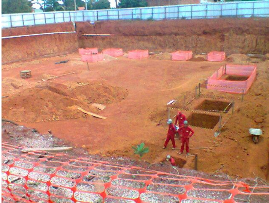
Figura 23 – Primeiras sapatas escavadas do projeto executado.
