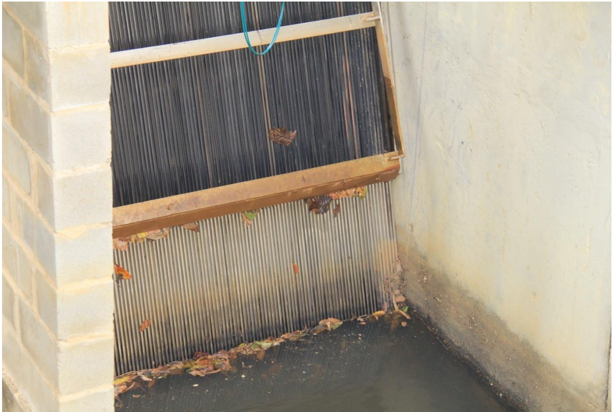
Figura 03: Grades automáticas.
