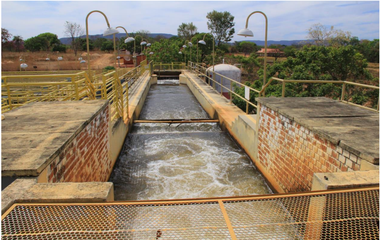
Figura 13: Canal da calha Parshall.
