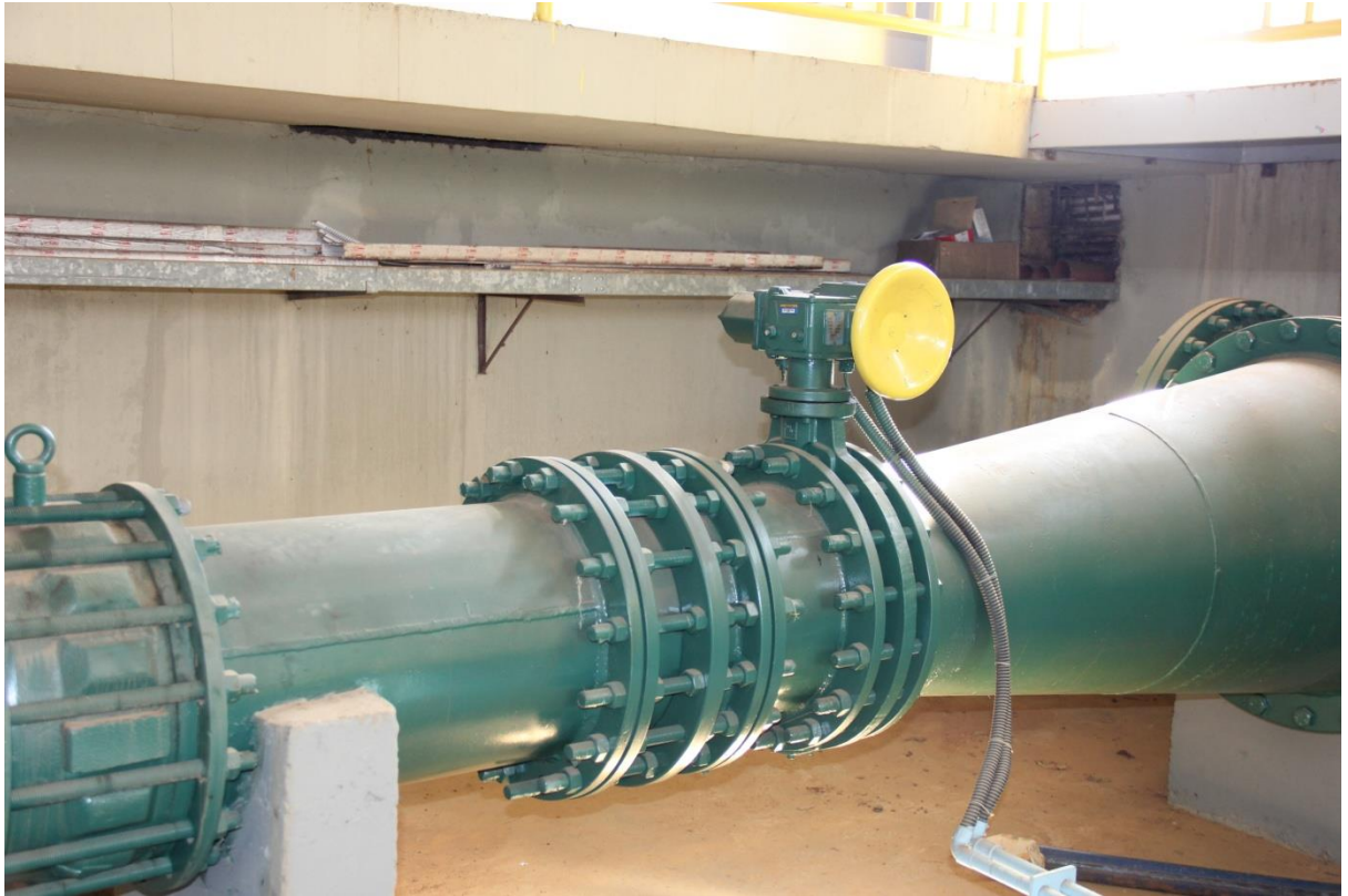
Figura 09: Válvula de gaveta.
