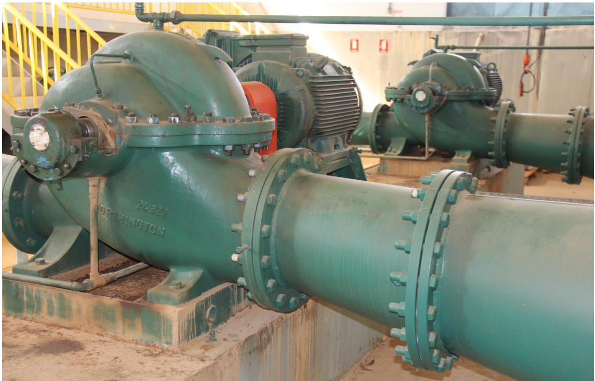
Figura 08: Bomba de sucção.
