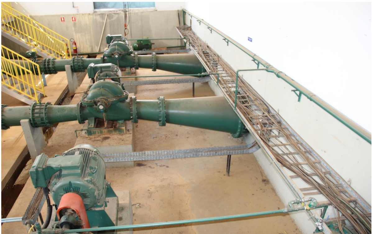
Figura 06: Tubulação de sucção.
