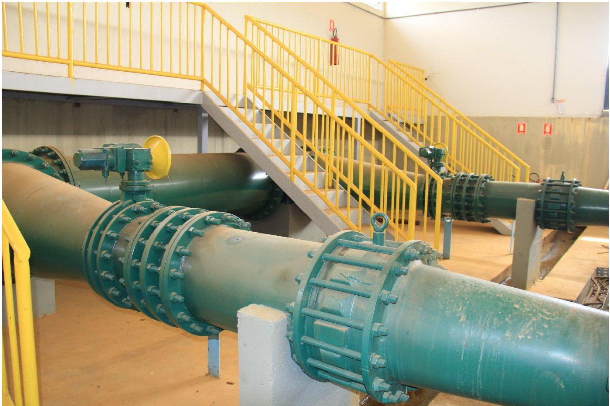
Figura 07: Tubulação de recalque.
