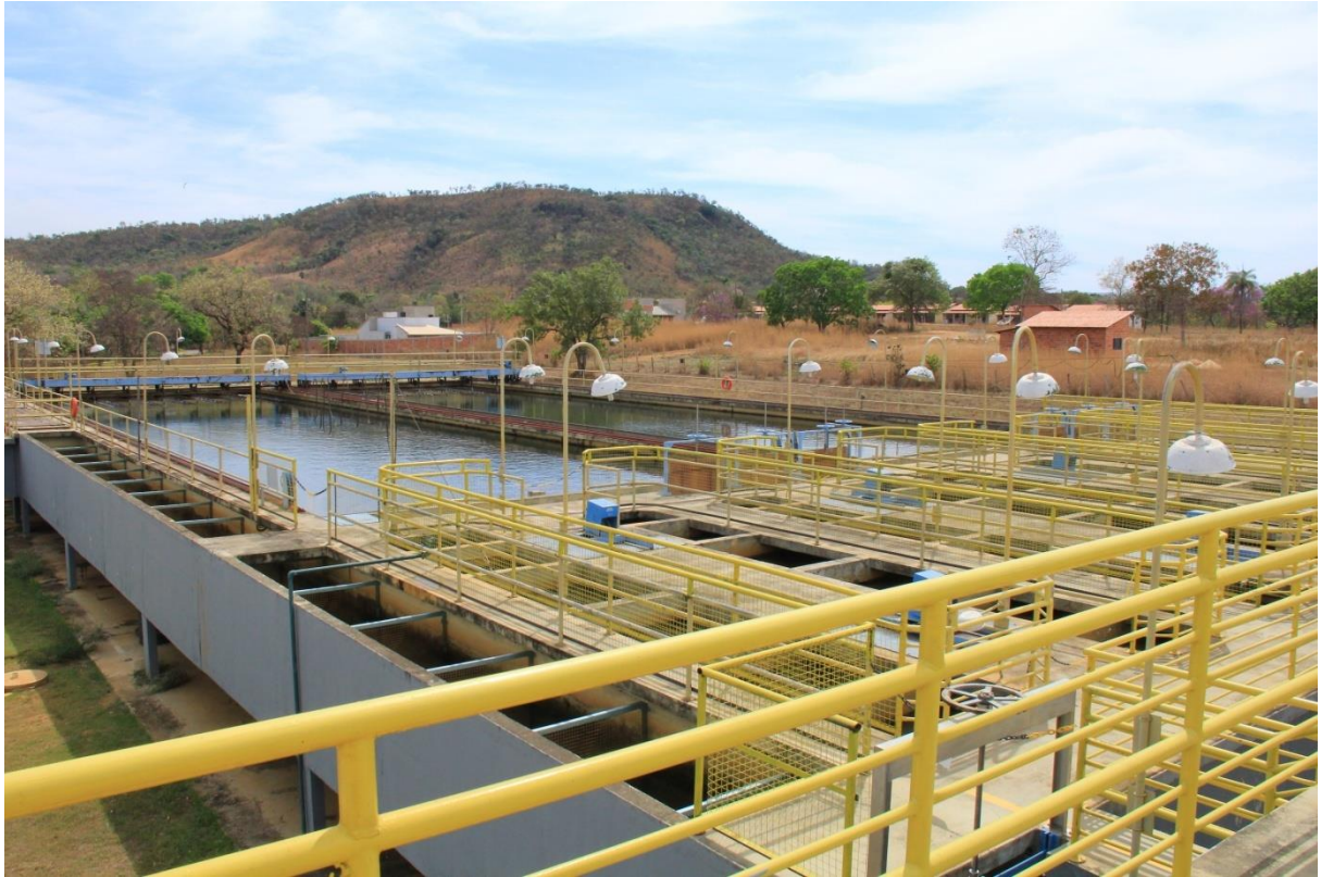
Figura 15: Floculadores e decantadores
