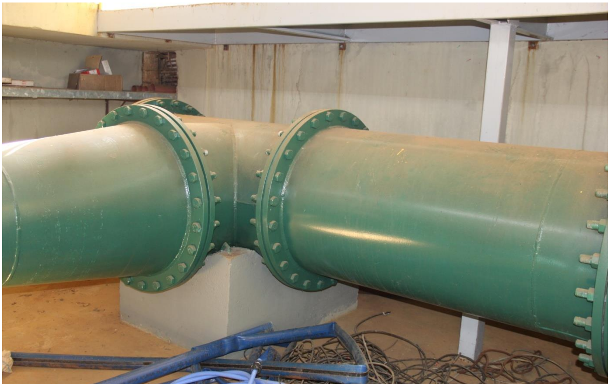
Figura 10: Conexões de recalque – Tê de FoFo.
