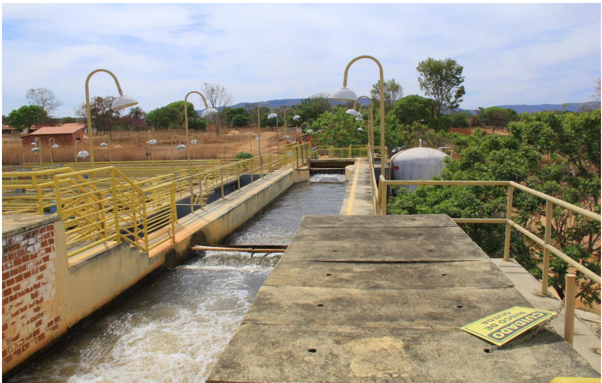
Figura 14: Canal da calha Parshall.
