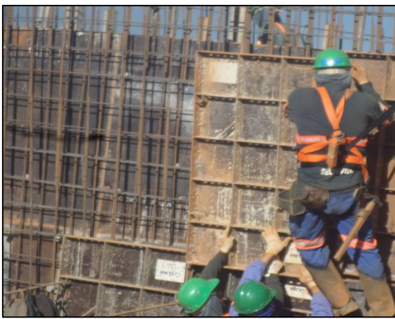
Figura 31 – Ausência de espaçadores em uma das faces da armadura da parede Fonte: Da autora (2015)
