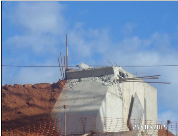
Figura 13 - Ninho de concretagem em sapata armada. Fonte: Da autora (2015)
