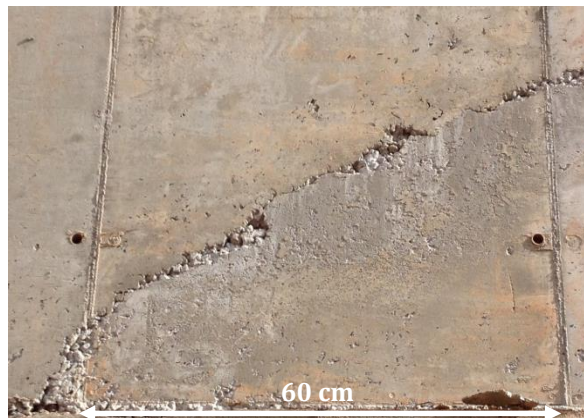
Figura 30 - Junta de concretagem na parede de concreto armado
