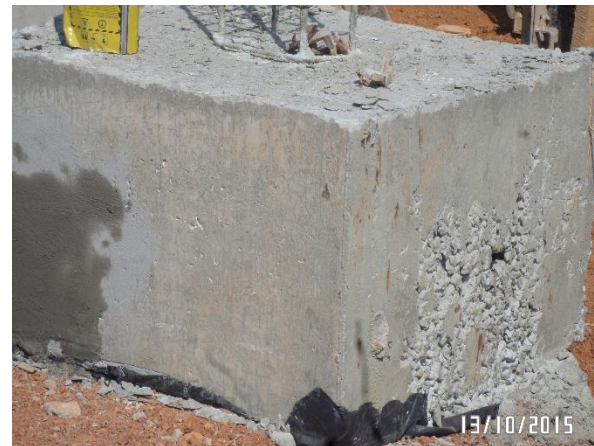
Figura 39 – Sapata com segregação Fonte: Da autora (2015)
