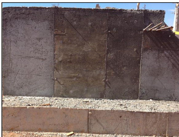
Figura 42 – Sapata com variação do tom Fonte: Da autora (2015)
