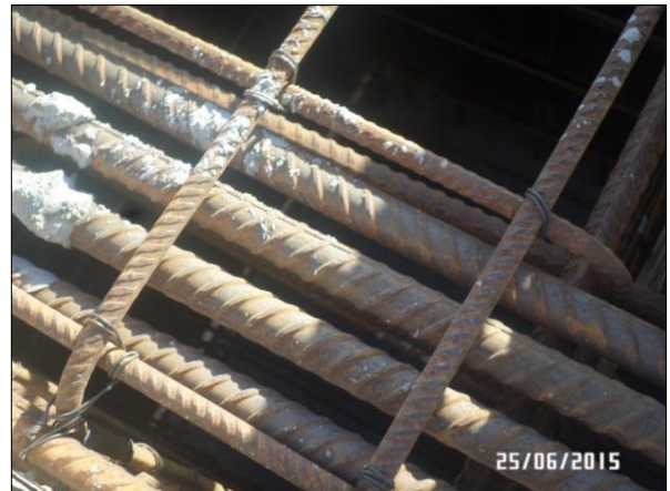
Figura 14 - Taxas elevadas de armadura Fonte: Da autora (2015)
