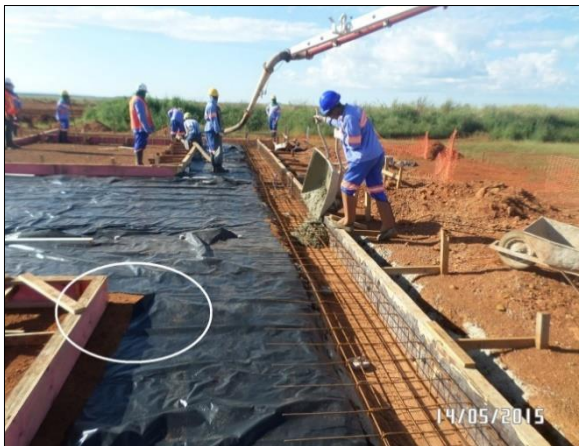
Figura 9. Interrupção de manta PEAD de dessolidarização
