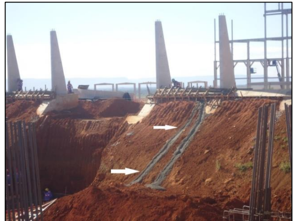
Figura 25 - Vazamento de concreto em forma de vigas Fonte: Da autora (2015)
