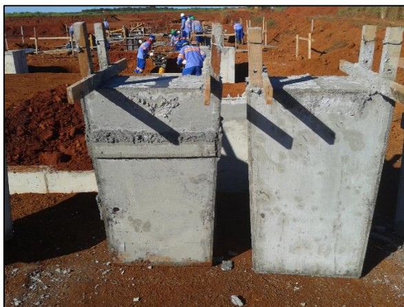
Figura 40 – Fôrmas sem limpeza Fonte: Da autora (2015)
