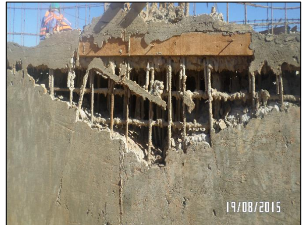
Figura 34 – Elevada quantidade de armadura Fonte: Da autora (2015)
