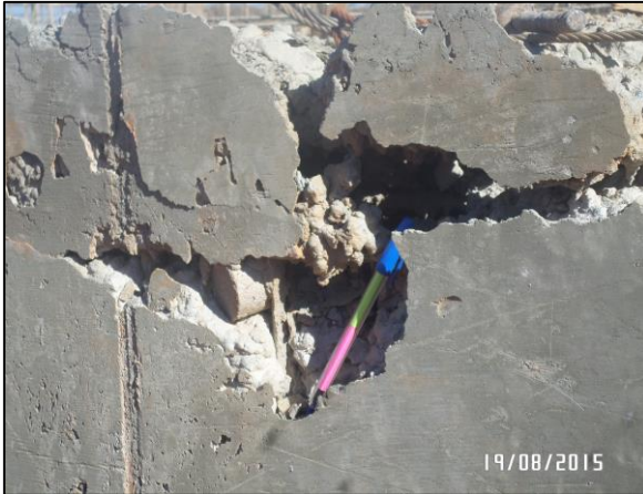
Figura 33 – Nicho de concretagem na parede Fonte: Da autora (2015)
