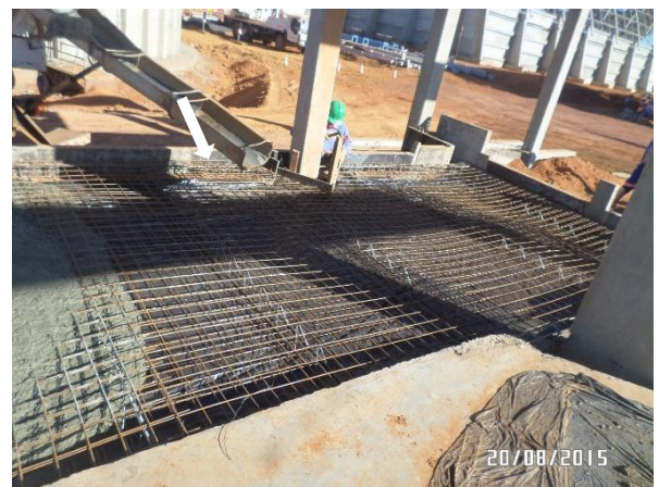
Figura 10. Concretagem do piso, com interrupção da manta PEAD
