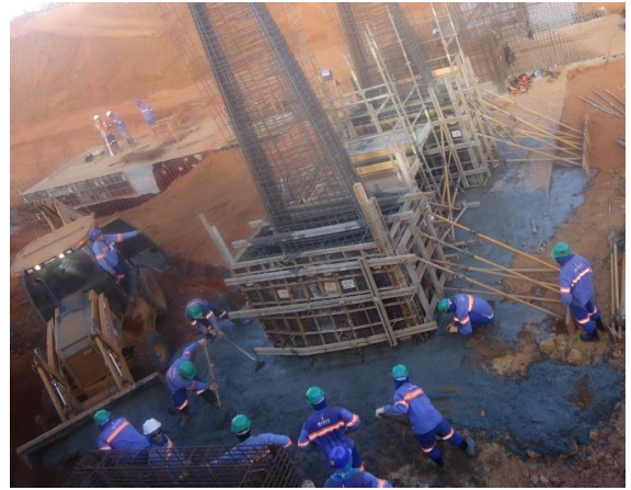
Figura 18 - Vazamento do concreto pela abertura da forma Fonte: Da autora (2015)
