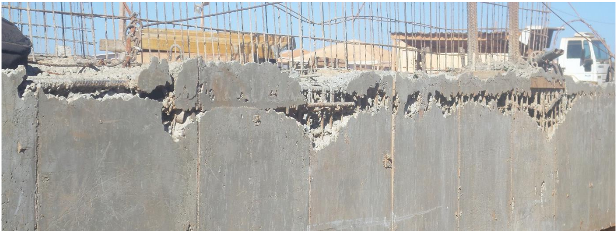
Figura 35 – Nicho de concretagem em toda extensão da parede Fonte: Da autora (2015)
