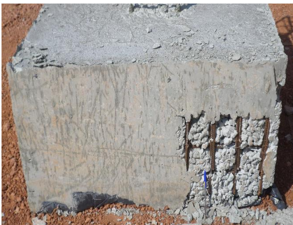
Figura 38 – Sapata com nicho de concretagem Fonte: Da autora (2015)
