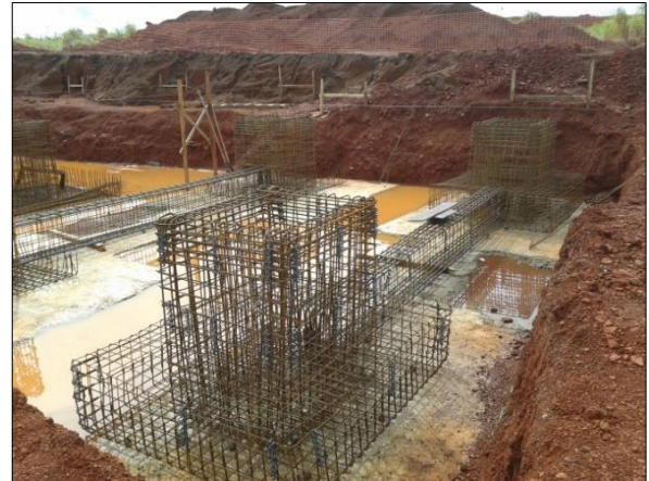
Figura 27 - Armaduras apoiadas em sarrafos de madeira Fonte: Da autora (2015)
