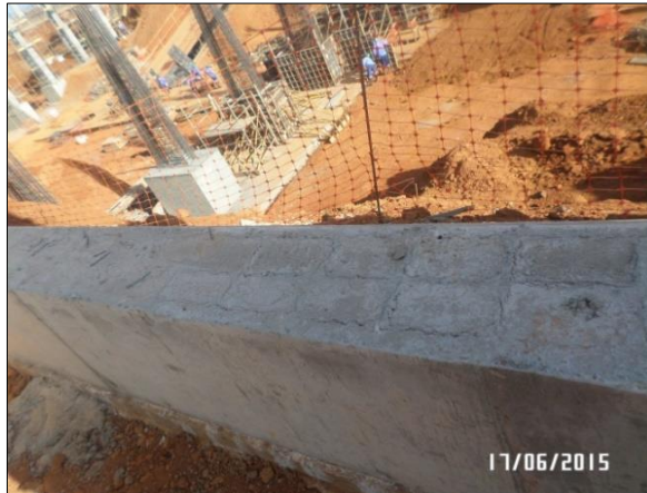
Figura 22 - Viga baldrame com fissuras mapeadas e ao longo das armaduras Fonte: Da autora (2015)
