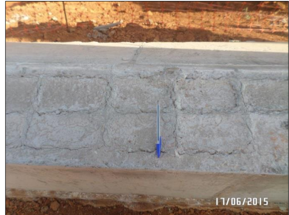
Figura 23 - Fissuras mapeadas em superfície superior de viga baldrame Fonte: Da autora (2015)
