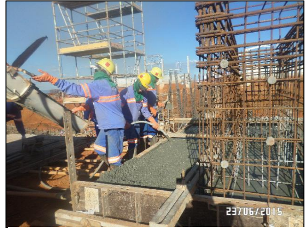
Figura 37 - Adensamento próximo à forma Fonte: Da autora (2015)
