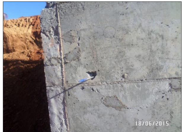
Figura 16 - Ninho de concretagem em arranque de sapata Fonte: Da autora (2015)
