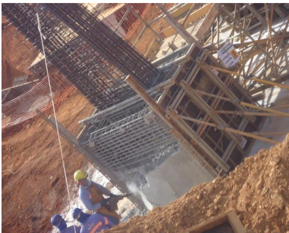
Figura 19 - Demolição de parte do cálice com martelo pneumático Fonte: Da autora (2015)
