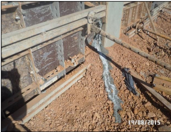
Figura 24 - Perda da nata de concreto pela junta Fonte: Da autora (2015)
