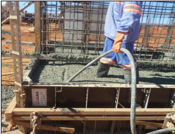
Figura 36 - Adensamento da base de uma sapata Fonte: Da autora (2015)
