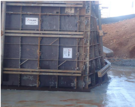
Figura 17 - Abertura da forma do cálice da sapata associada Fonte: Da autora (2015)
