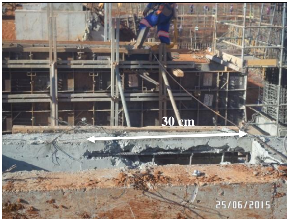
Figura 15 - Ninho de concretagem em extremidade superior da sapata Fonte: Da autora (2015)
