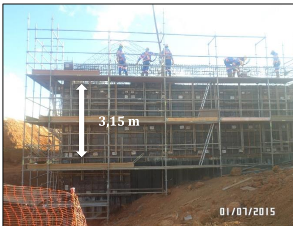
Figura 28 – Concretagem da parede de concreto armado Fonte: Da autora (2015)
