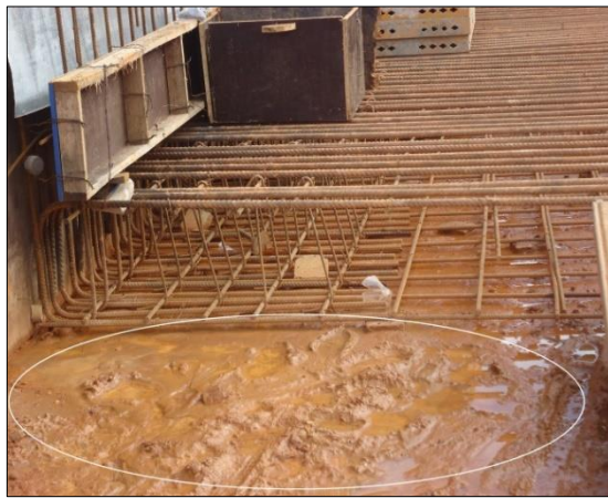
Figura 11. Armadura de piso em contato com terreno encharcado e instável Fonte: Da autora (2015)
