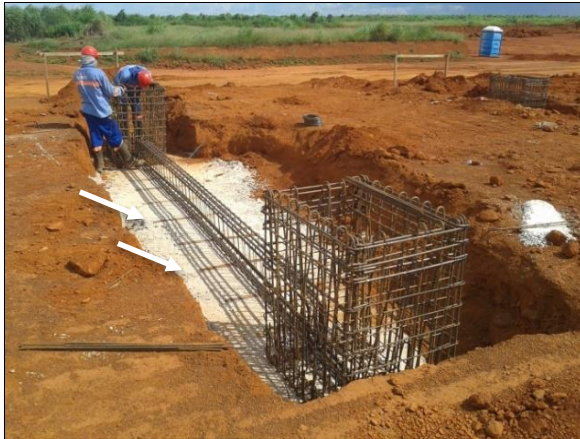
Figura 26 - Armaduras de vigas apoiadas em sarrafos de madeira Fonte: Da autora (2015)
