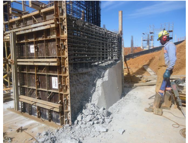
Figura 20 - Demonstração do ponto máximo de retirada do concreto Fonte: Da autora (2015)
