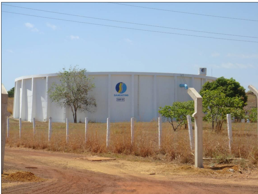
Figura 32 – “Depois” da intervenção feita no RAP 001
