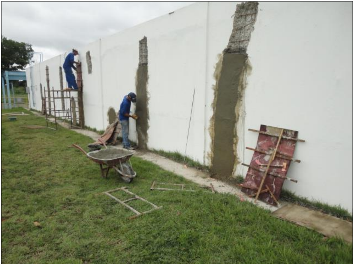
Figura 33 – Reforço estrutural no RAP 009
