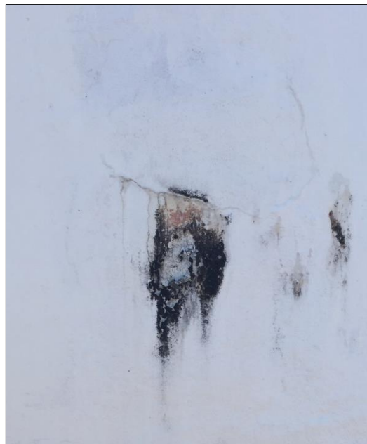
Figura 22 – RAP 009: PAREDE DO RESERVATÓRIO
