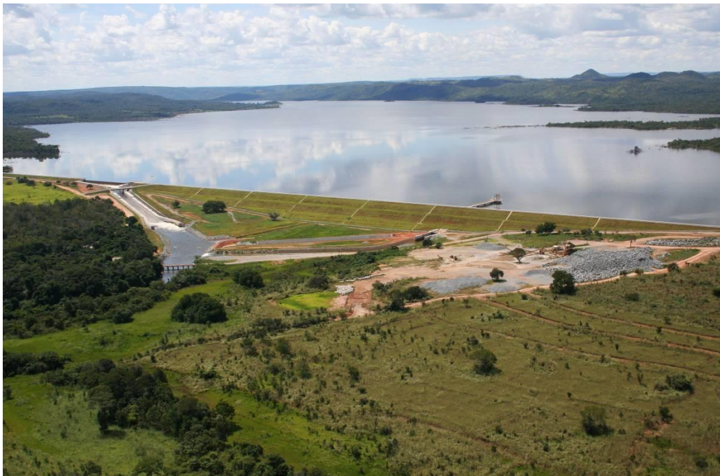
Figura 9 - Visão geral da área do barramento do reservatório
