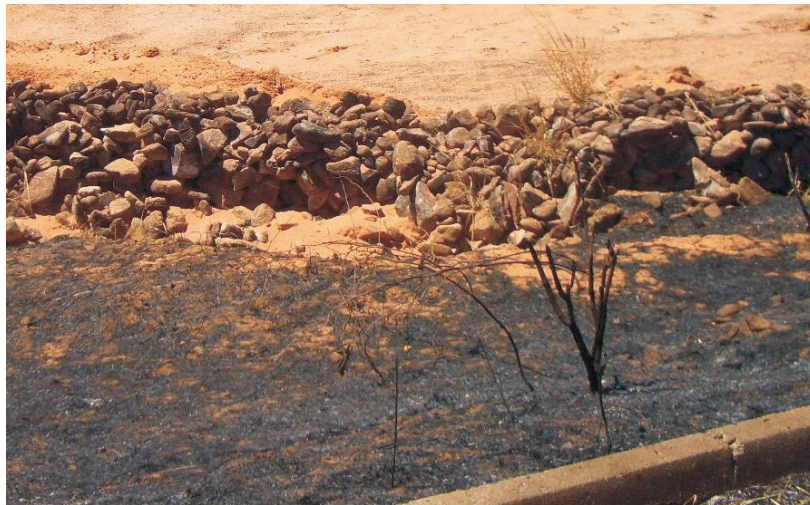
Figura 20 - Construção de muros de pedras para combate à erosão Fonte: SRHMA
