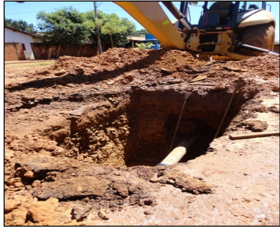
Figura 18 - Intervenção para troca de colar e ramal de ligação. Fonte: Do autor (2015)
