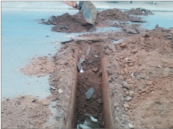
Figura 4 - Abertura de vala com retroescavadeira. Fonte: Do autor (2015)
