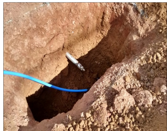
Figura 11 - Chegada de perfuratriz rede de água. Fonte: Do autor (2015)
