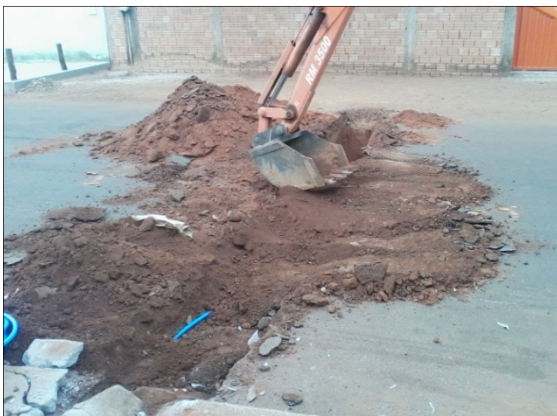
Figura 6 - Fechamento de vala com apoio de retro. Fonte: Do autor (2015)
