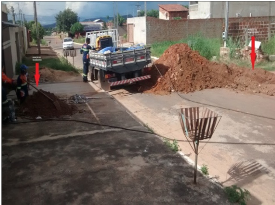
Figura 8 - Posicionamento da rede e do hidrômetro de ligação. Fonte: Do autor (2015)
