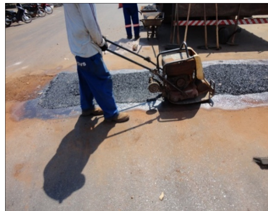
Figura 7 - Recomposição de pavimento asfáltico. Fonte: Do autor (2015)
