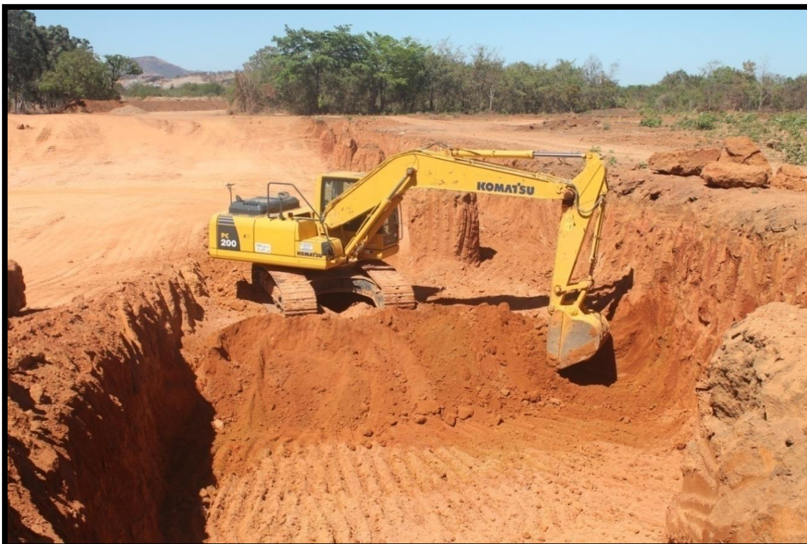
Figura 9 - Escavação da nova célula do Aterro Sanitário de Palmas.
