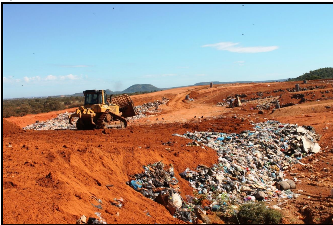
Figura 6 - Retroescavadeira fazendo a cobertura do lixo depositado.
