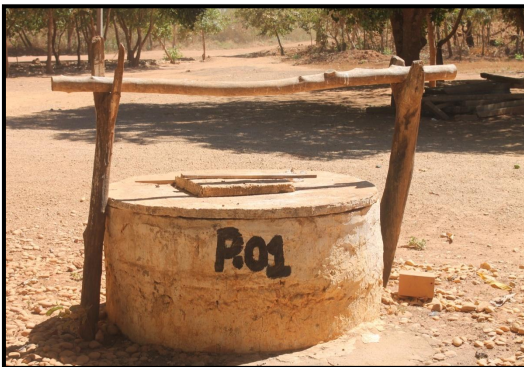
Figura 17 - Poço de monitoramento situado na montante do Aterro Sanitário.
