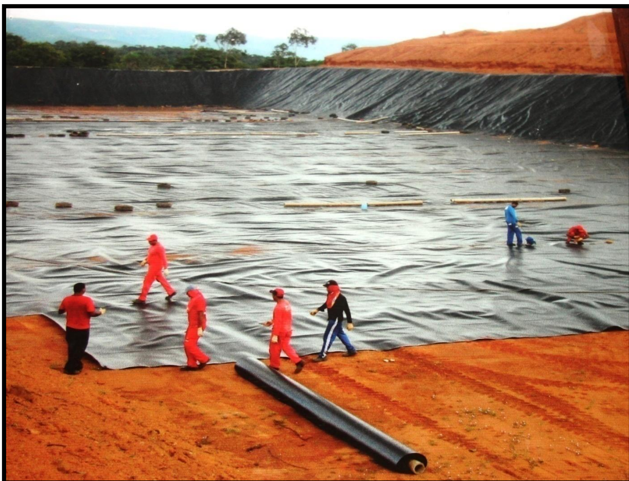
Figura 7 - Serviço de impermeabilização da base e laterais do aterro.
