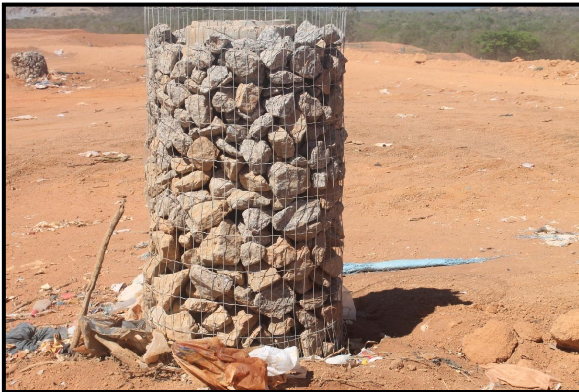
Figura 11 - Drenos de gás a 20 metros de aterro de resíduos.
