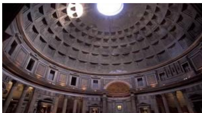
Figura 2 - Panteão Romano. Fonte: Associação Brasileira de Cimento Portland
