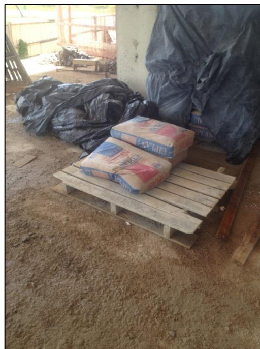
Figura 14: Armazenamento de cimento. Fonte: Autor, 2015.
