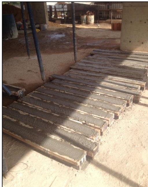
Figura 20: Vergas para vãos de alvenaria. Fonte: Autor, 2015.
