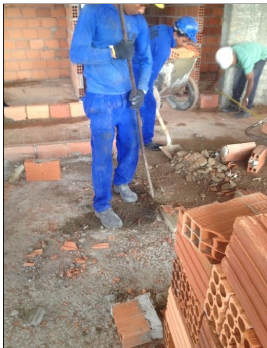
Figura 24: Ajuste em painel inadequado. Fonte: Autor, 2015.
