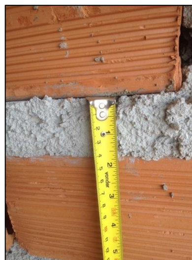
Figura 30: Altura da junta de assentamento. Fonte: Autor, 2015.
