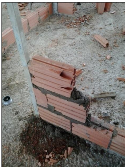
Figura 25: Levantamento de painéis pelos cantos. Fonte: Autor, 2015.
