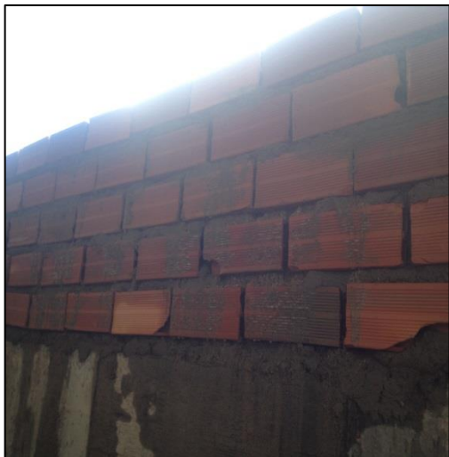
Figura 40: Alvenaria executada em das de chuva. Fonte: Autor, 2015.
