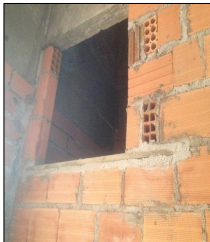
Figura 47: Contra verga, dimensões baixas.
