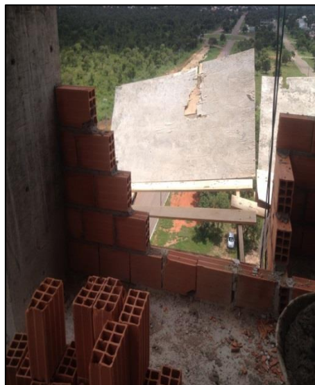
Figura 26: Levantamento painéis pela extremidade. Fonte: Autor, 2015.
