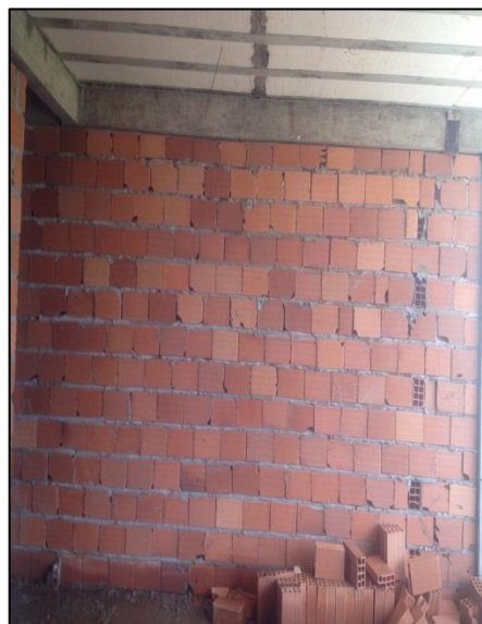
Figura 49: Junta de fechamento. Fonte: Autor, 2015.
