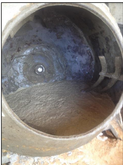
Figura 42: Argamassa em betoneira. Fonte: Autor, 2015.
