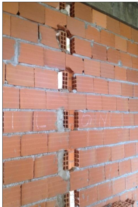
Figura 33: Encontro painéis Fonte: Autor, 2015.
