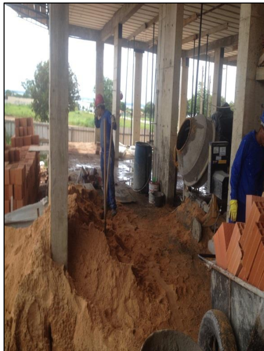
Figura 16: Armazenamento agregado miúdo. Fonte: Autor, 2015.
