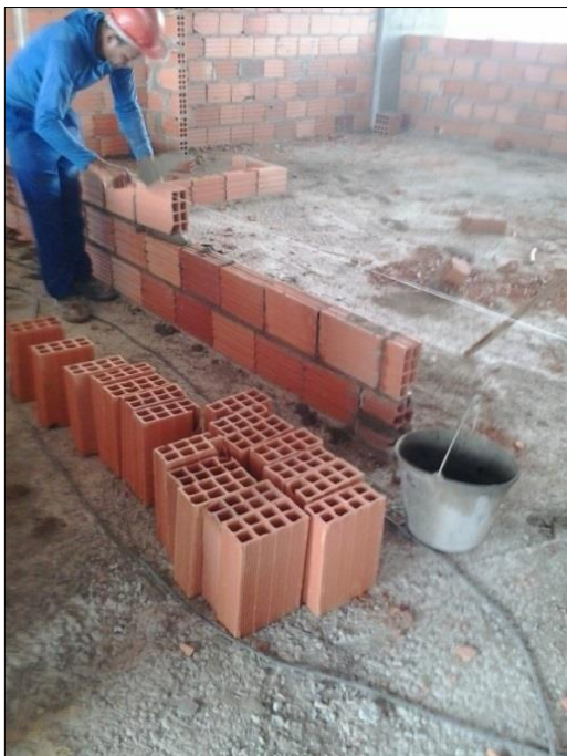
Figura 27: Junta a prumo. Fonte: Autor, 2015.
