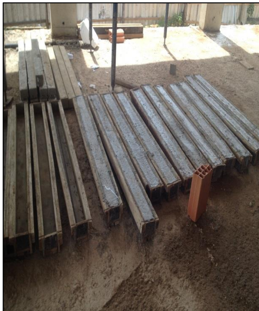
Figura 19: Confeção das vergas. Fonte: Autor, 2015.
