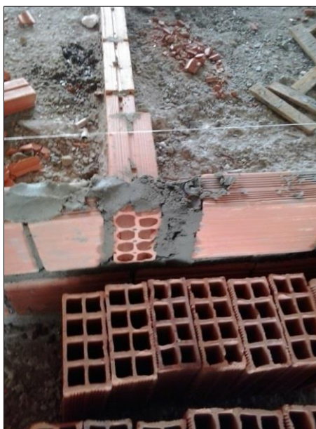
Figura 31: Encontro de painéis. Fonte: Autor, 2015.
