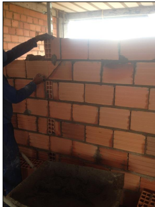
Figura 28: Junta de amarração. Fonte: Autor, 2015.
