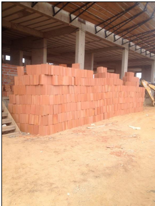
Figura 17: Estocagem de tijolos. Fonte: Autor, 2015.
