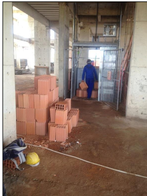
Figura 18: Transporte de bloco cerâmico. Fonte: Autor, 2015.
