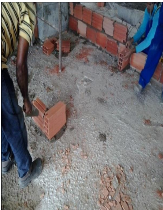
Figura 23: Marcação da primeira fiada. Fonte: Autor, 2015.
