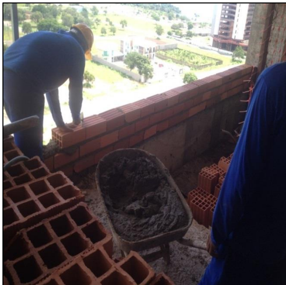
Figura 34: Não utilização ferro cabelo e chapisco no pilar. Fonte: Autor, 2015.
