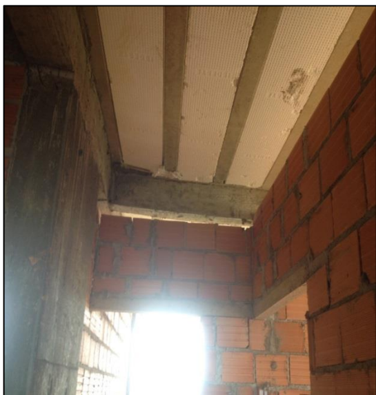
Figura 48: Junta de encunamento. Fonte: Autor, 2015.
