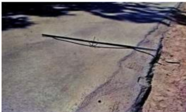
Figura 03 - Afundamento por trilha de roda
