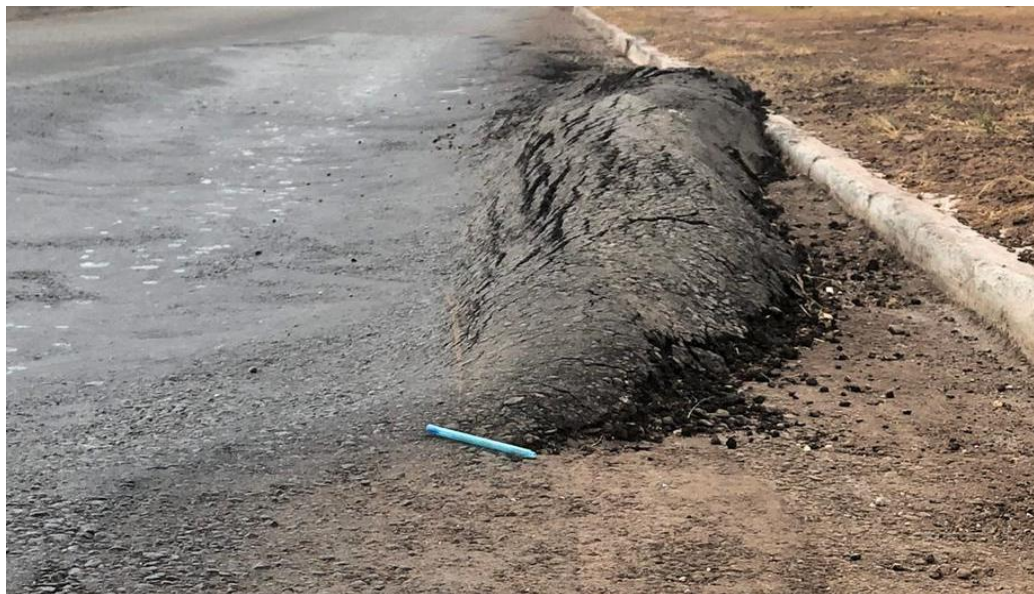
Figura 22- Afundamento
