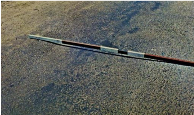
Figura 04- Afundamento local
