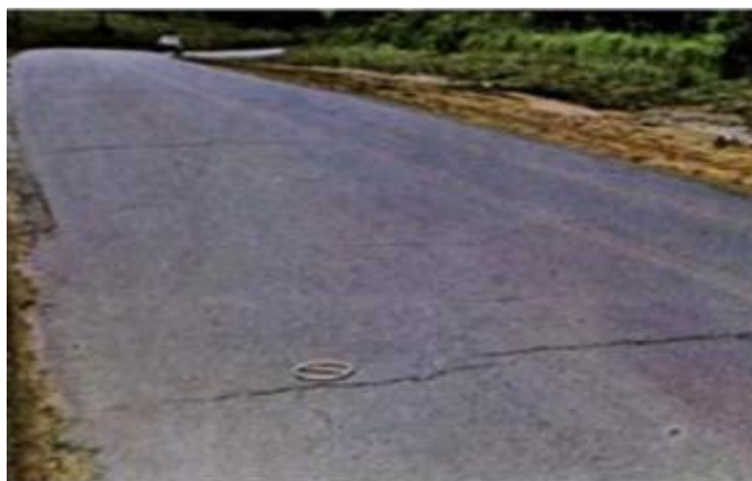
Figura 06 – Trinca transversal
