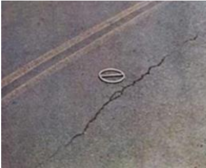
Figura 07 - Trinca longitudinal
