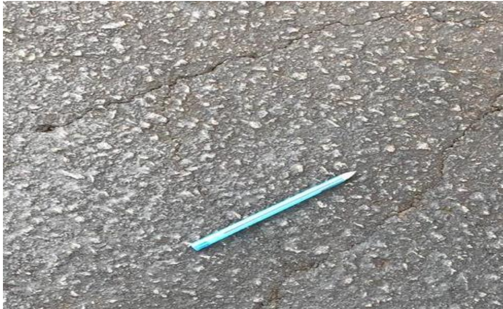
Figura 21- trincas isolada
