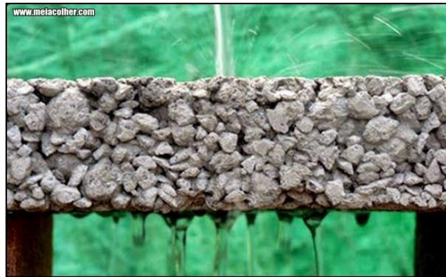
Figura 8: Alta permeabilidade e índice de vazios do concreto poroso.
