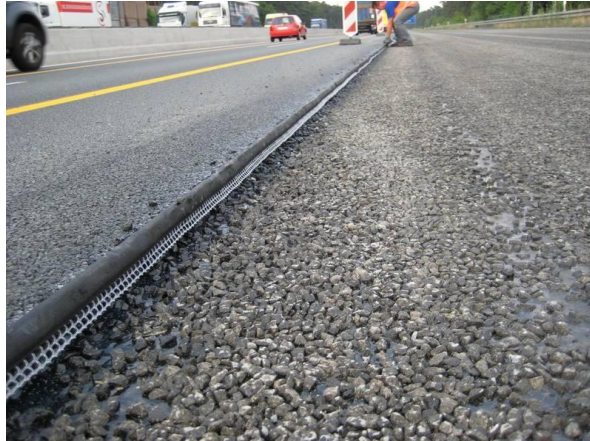
Figura 4: Aplicação de pavimento de concreto permeável em uma rodovia.
