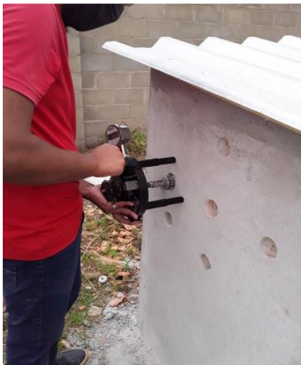
Figura 36 – Ensaio de resistência de aderência a tração.
