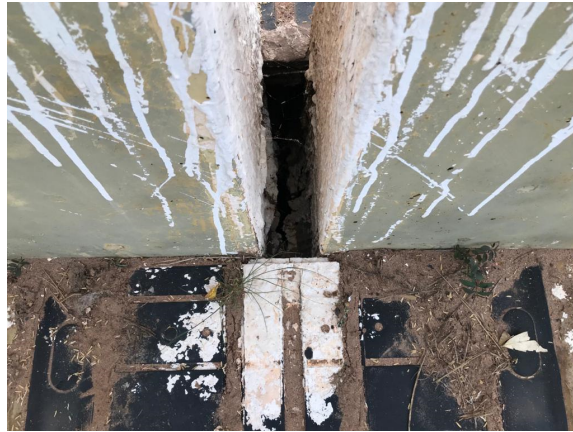
Figura 52 – Junta de dilatação do guarda rodas, sentido Sul-Norte
