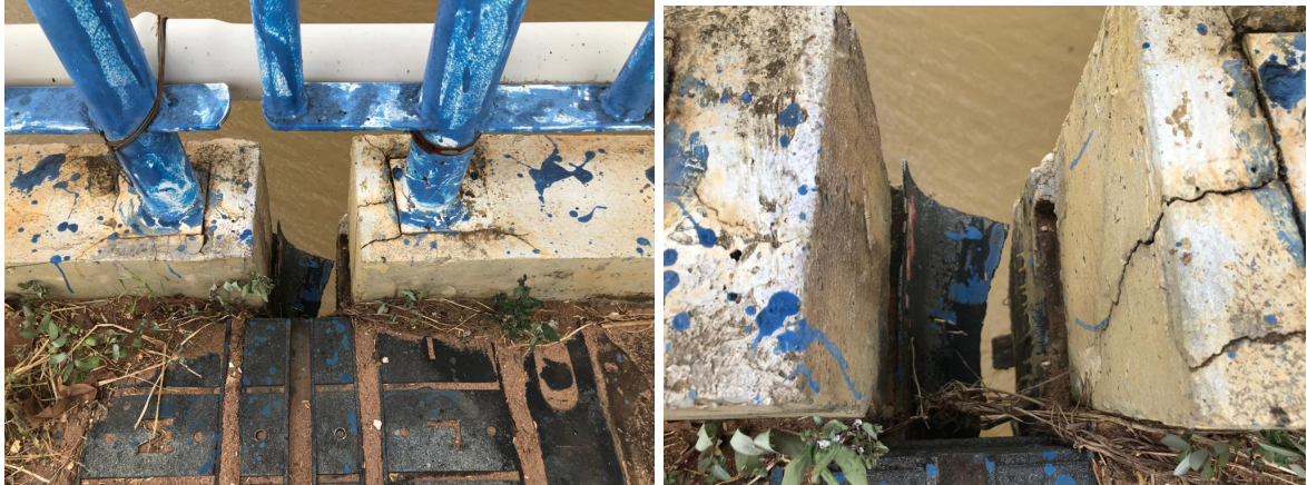
Figura 54 – Drenagem da área de pedestre, sentido Sul-Norte
