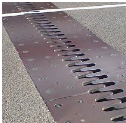
Figura 6 – Junta dentada
