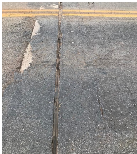
Figura 57 – Faixa central, sentido Sul-Norte
