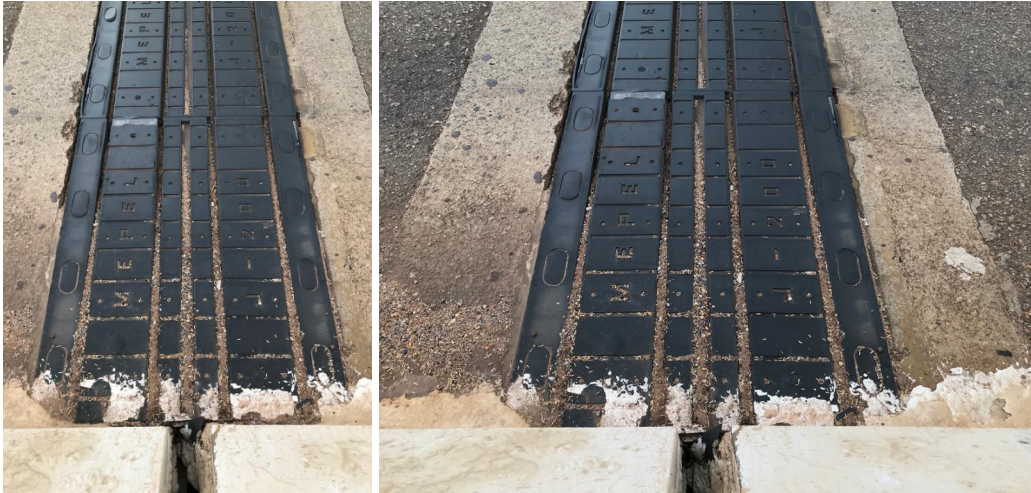
Figura 46 – Pista de tráfego próximo ao guarda rodas, sentido Norte-Sul.
