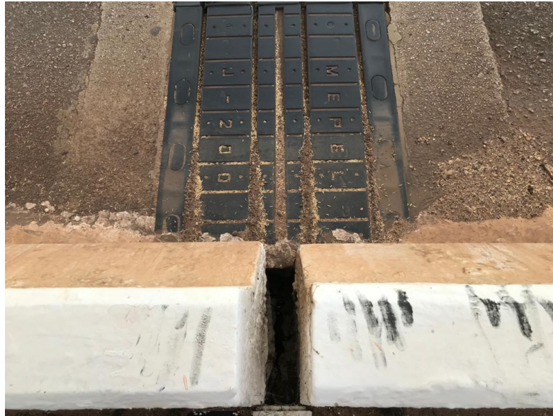
Figura 50 - Pista de tráfego próximo ao guarda rodas sentido Sul-Norte.
