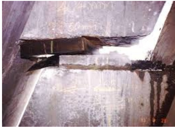
Figura 5 – Junta deslizante
