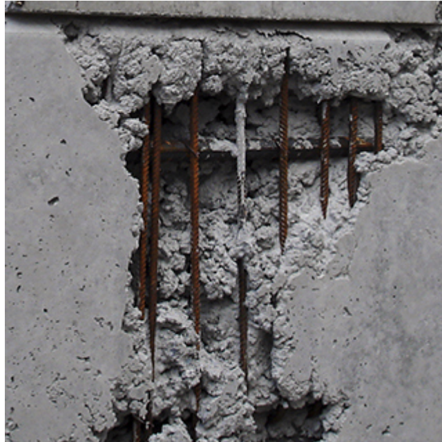
Figura 14 – Nicho de concretagem
