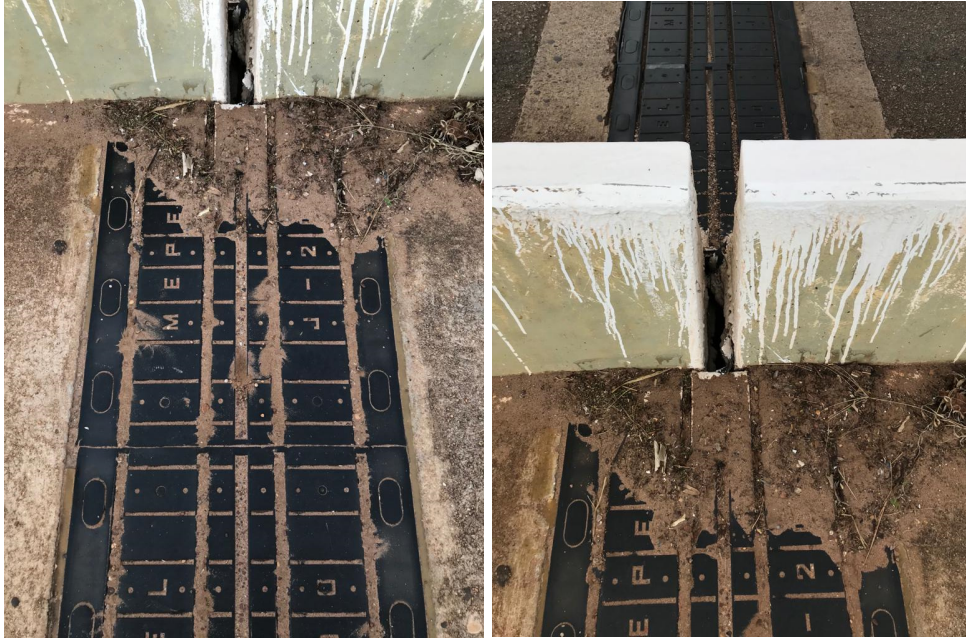
Figura 42 – Área de pedestre da junta 2, sentido Norte-Sul
