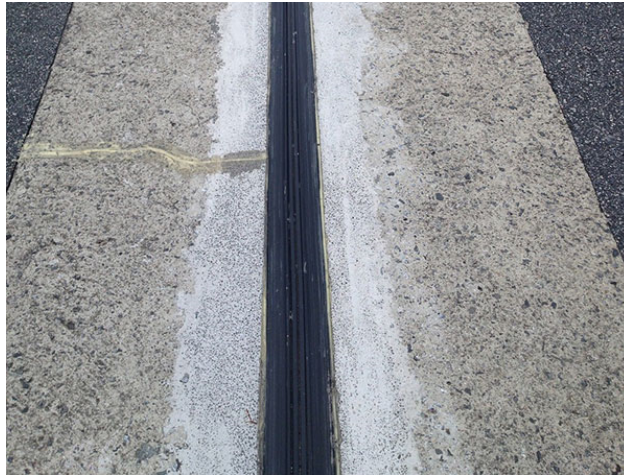
Figura 3 – Junta fechada
