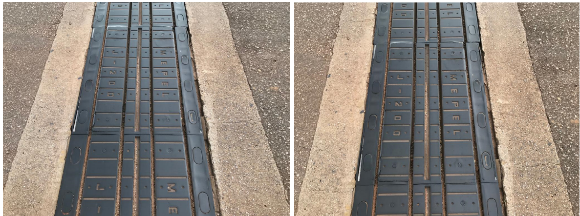
Figura 51 - Segunda faixa de tráfego sentido Sul-Norte
