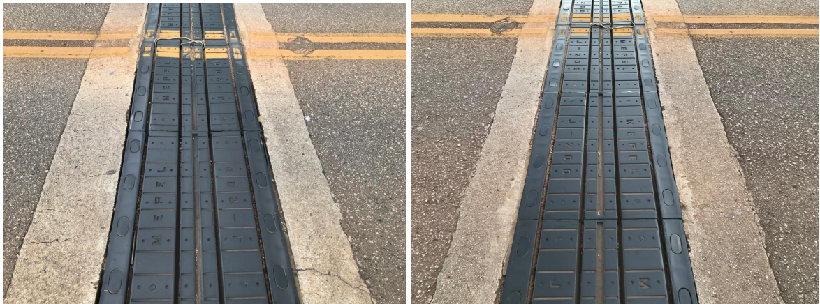
Figura 48 – Faixas centrais da junta de dilatação
