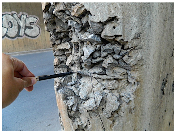
Figura 13: falha de concretagem ( F_i = 3 )
