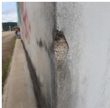
Figura 35: Danos dos Pilones do APOIO 7.
