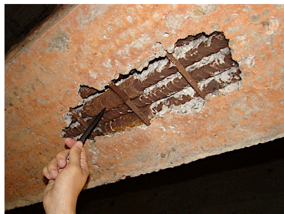
Figura 14: falha de concretagem ( F_i = 3 )
