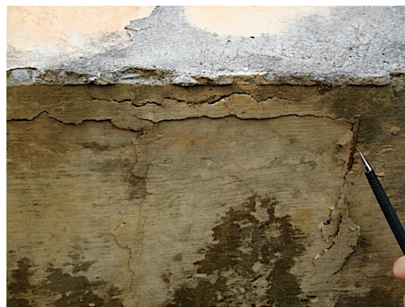
Figura 2: corrosão de armadura ( F_i = 3 )
