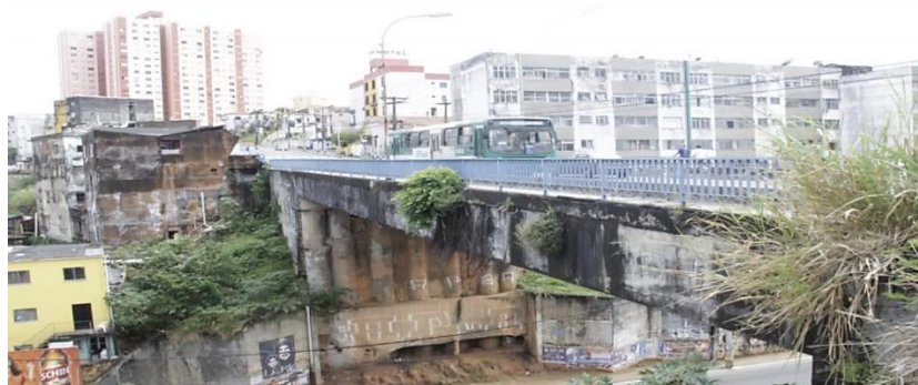
Figura 28: Umidade excessiva em OEAs.
