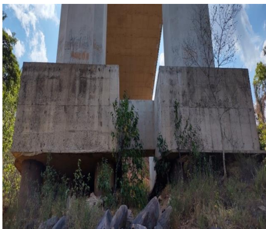
Figura 36: Manchas de Bolor no bloco de fundação BF4, BF5 e BF6.
