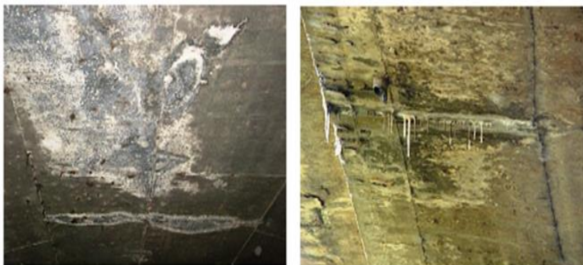
Figura 25: Formação de eflorescência em lajes sem e com estalactites.
