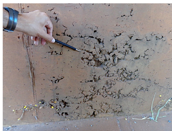
Figura 12: falha de concretagem ( F_i = 2 )
