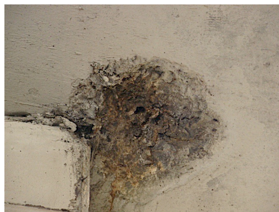
Figura 4: desagregação ( F_i = 2 )
