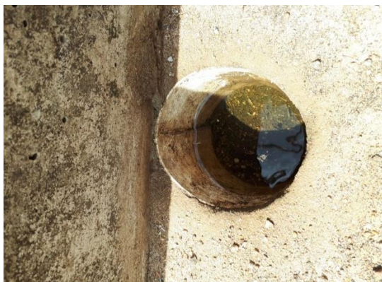
Figura 56: Tubulação de drenagem obstruída.
