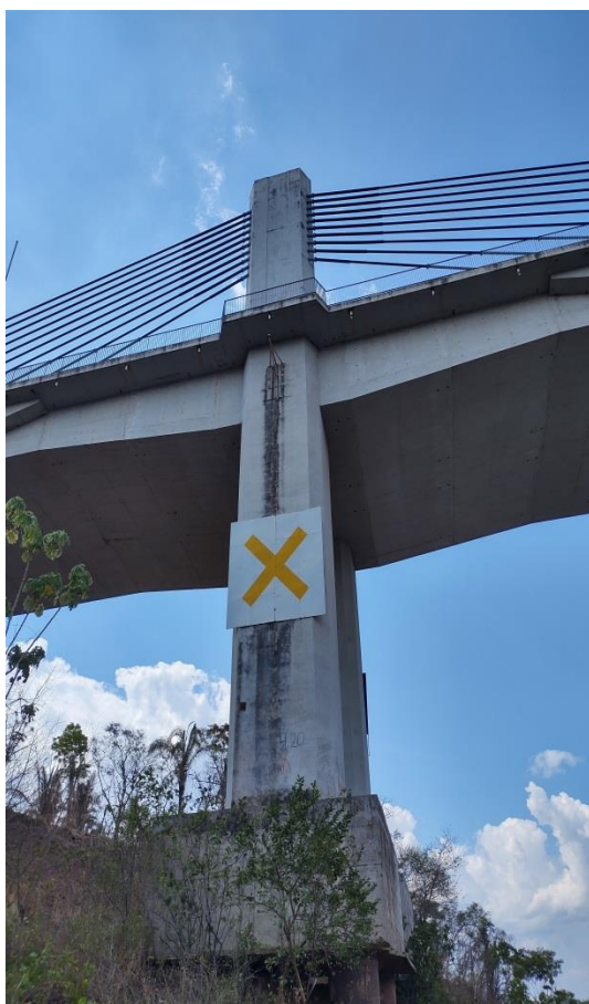
Figura 39: Mancha nos pilares 5 e 9.
