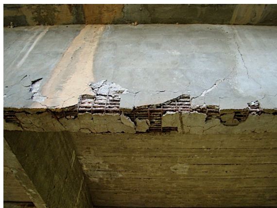
Figura 15: falha de concretagem ( F_i = 4 )
