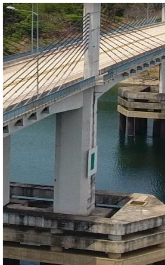
Figura 39: Mancha nos pilares 5 e 9.
