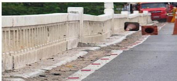
Figura 24: Flecha excessiva
