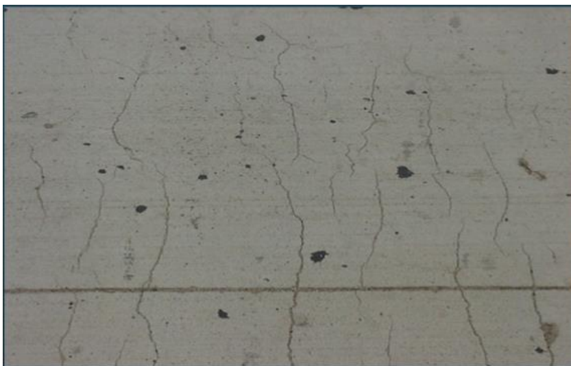
Figura 19: Fissuras de Retração Plástica.
