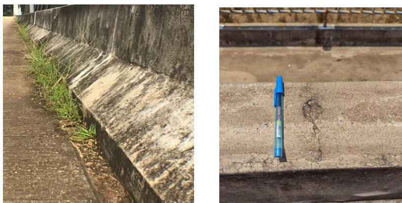
Figura 44: Barreira rígida com manchas e deslocamento do concreto.
