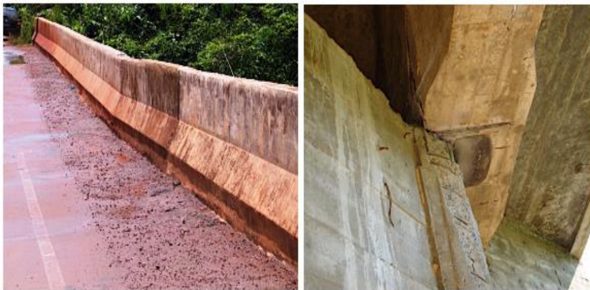
Figura 16: Desalinhamento da barreira de proteção e aparelho de apoio fora no lugar.
