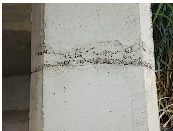
Figura 11: falha de concretagem ( F_i = 1 )
