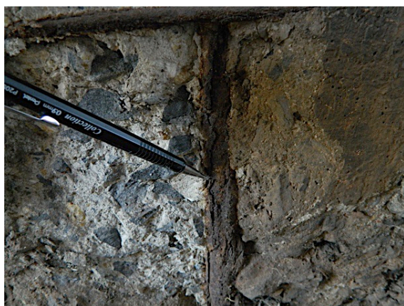
Figura 3: corrosão de armadura ( F_i = 4 )
