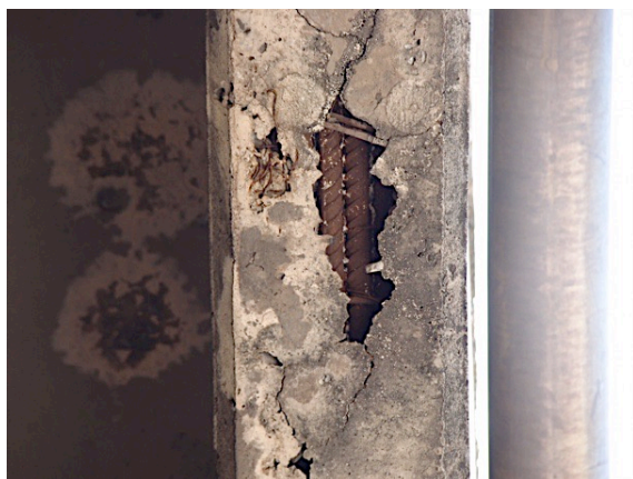
Figura 1: corrosão de armadura ( F_i = 2 )
