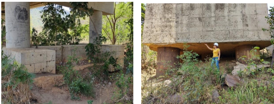
Figura 38: Aterros dos apoios 2 e 4.
