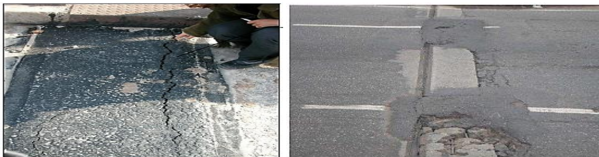
Figura 27: Obstrução da junta de dilatação com pavimento.
