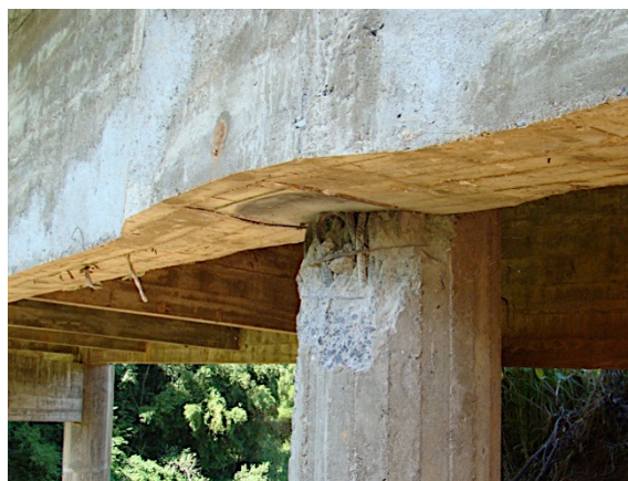
Figura 20: sinais de esmagamento do concreto ( F_i = 4 )
