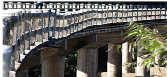
Figura 24: Flecha excessiva
