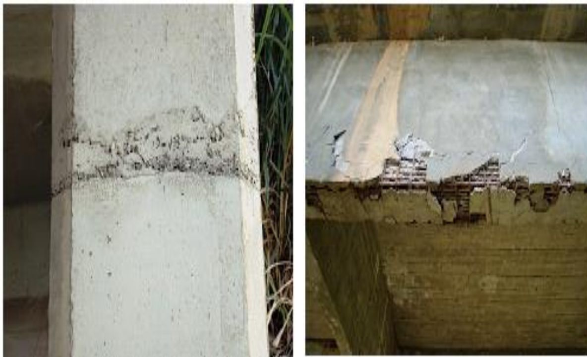
Figura 18: Falhas na concretagem.
