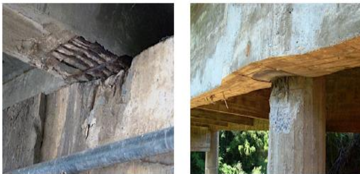
Figura 17: Esmagamento do concreto
