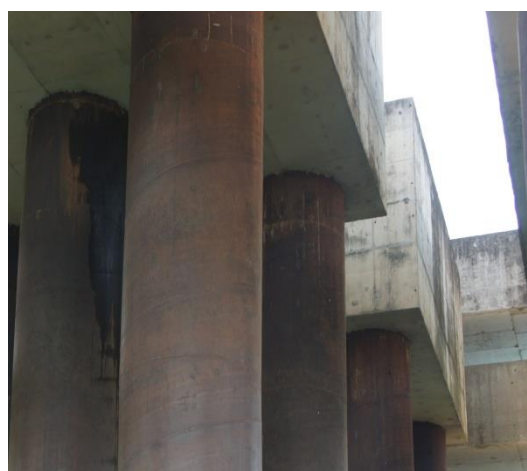
Figura 36: Manchas de Bolor no bloco de fundação BF4, BF5 e BF6.
