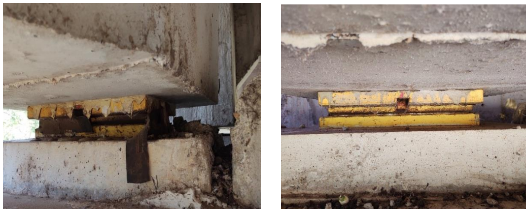
Figura 50: Aparelho de apoio do apoio 1.
