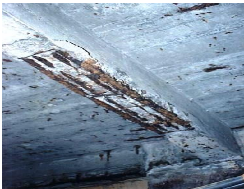
Figura 15: Deslocamento de concreto devido corrosão das armaduras.
