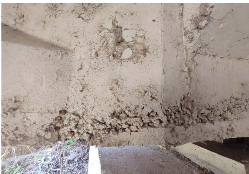
Figura 42: Falha de concretagem na Longarina VL 5.
