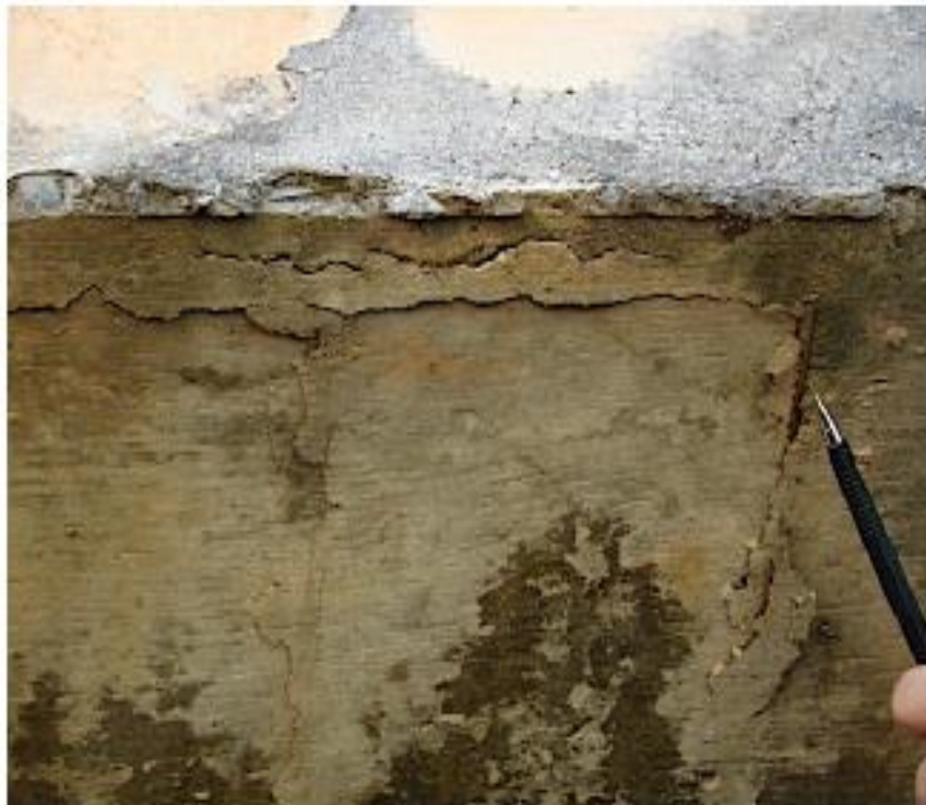
Figura 23: Fissura de corrosão
