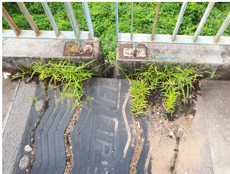
Figura 47: Junta de dilatação com vegetação.
