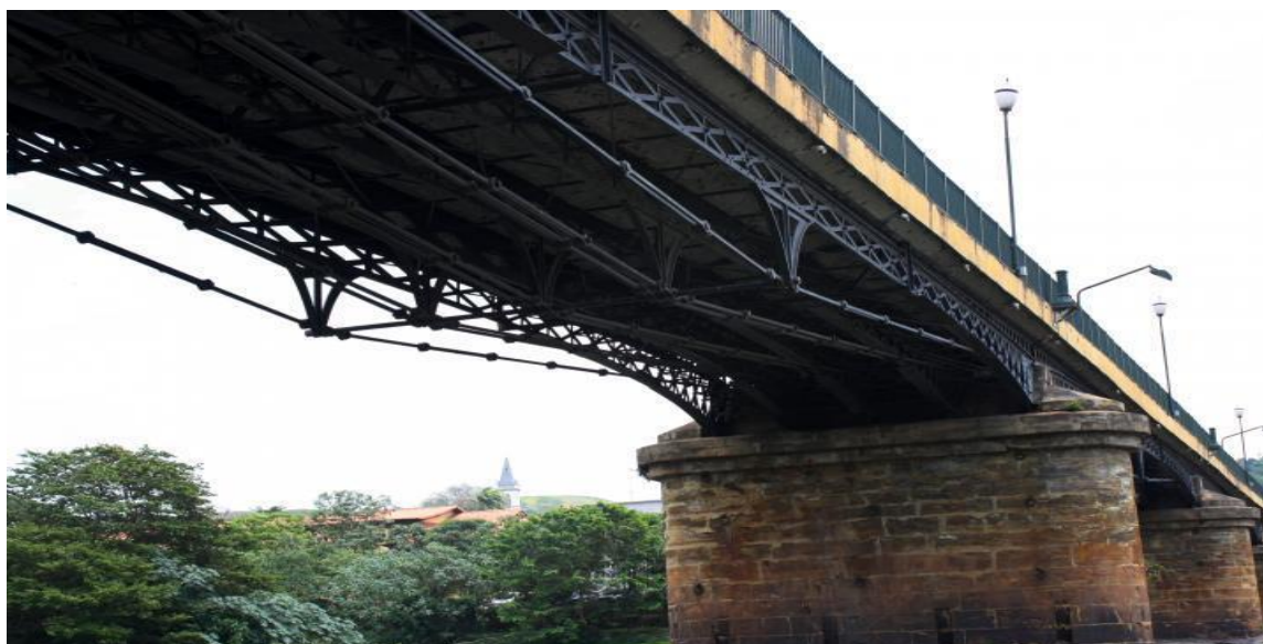
Figura 1 - Ponte de Paraíba do Sul no estado do Rio de Janeiro.
