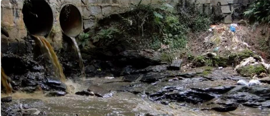
Figura 1: Despejo de esgoto não tratado
