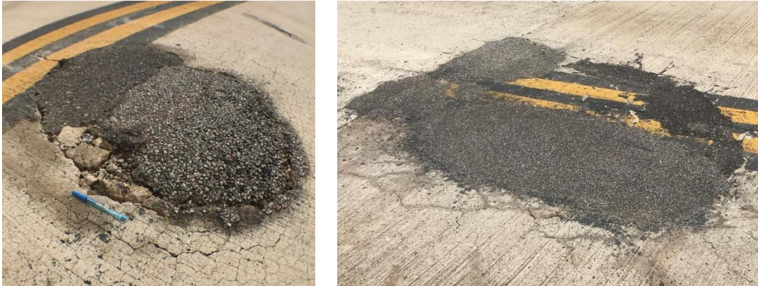
Figura 23 - Reparos no vão central da ponte
