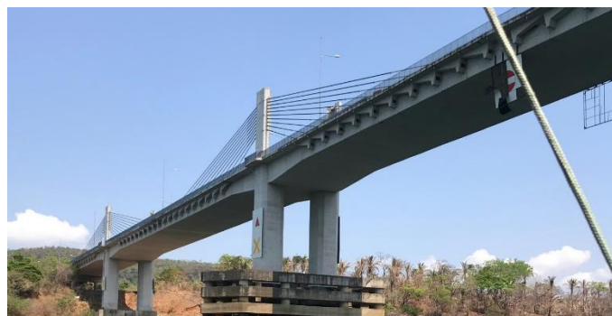
Figura 47 - Sinalização náutica do vão central
