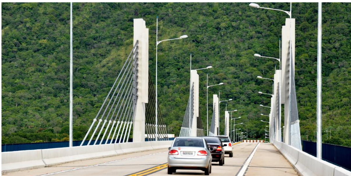
Figura 16 - Vista da Pista de Rolamento da Ponte dos Imigrantes Nordestinos
