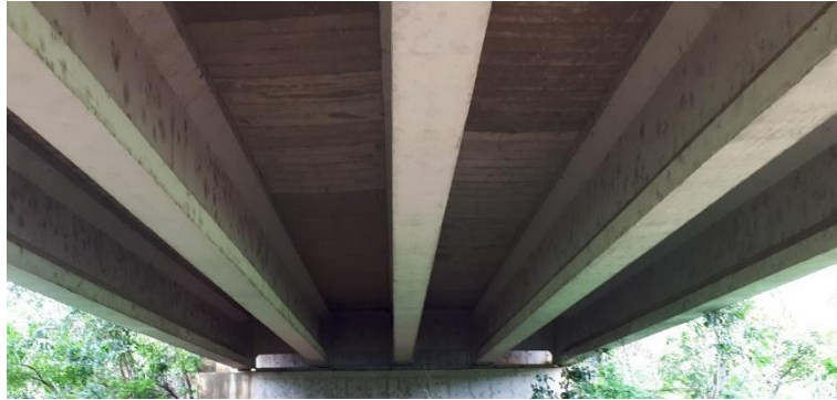
Figura 38 - Vigamento Vão Lateral sentido Miracema / Lajeado - TO
