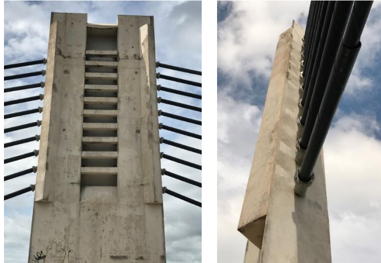
Figura 36 - Ancoragem dos estais no pilone
