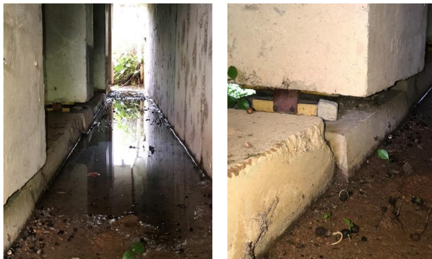
Figura 33 - Acesso aos aparelhos de apoio
