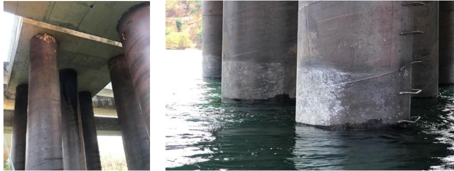
Figura 45 - Estacas do vão central da ponte
