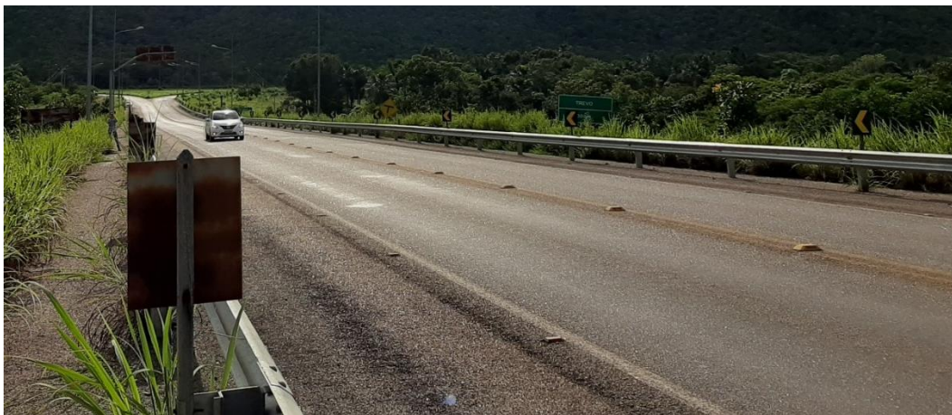
Figura 20 - Vista acesso ponte sentido Lajeado / Miracema - TO
