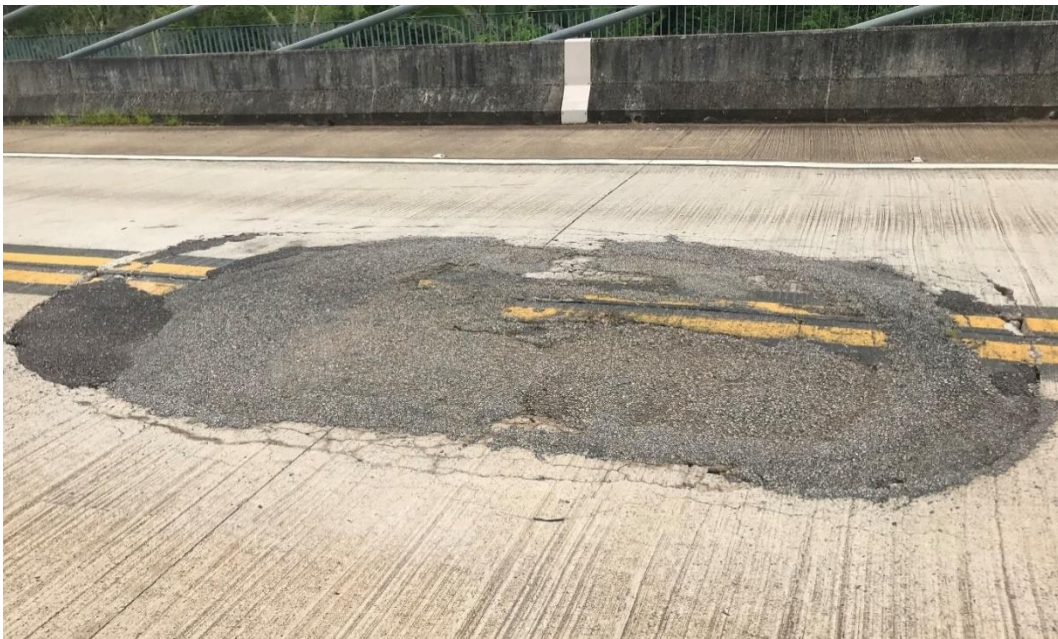
Figura 22 - Reparo no primeiro vão da ponte sentido Lajeado / Miracema - TO
