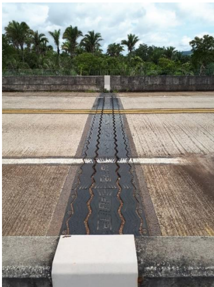
Figura 24 - Junta de dilatação
