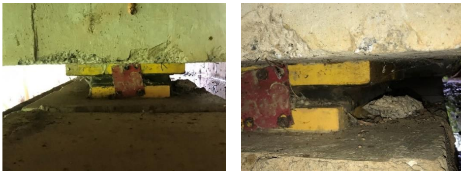
Figura 32 - Aparelho de apoio
