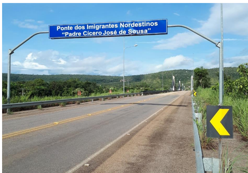
Figura 17 - Ponte do Imigrantes Nordestinos sentido Lajeado / Miracema - TO
