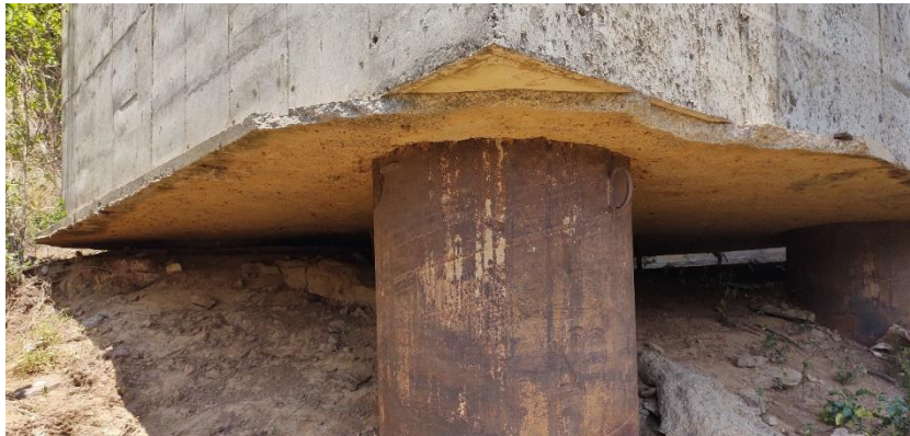
Figura 44 - Borda inferior da parede do apoio
