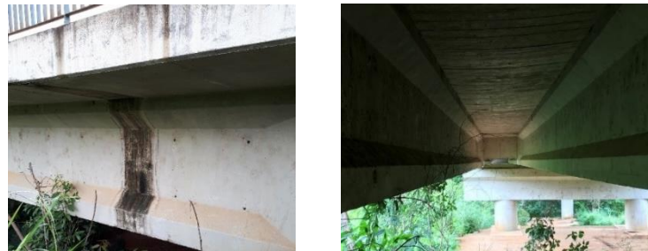
Figura 39 - Vigamento Vão Lateral sentido Lajeado / Miracema - TO
