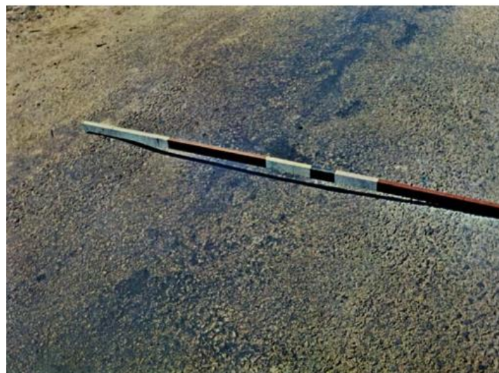
Figura 11- Afundamento Local
