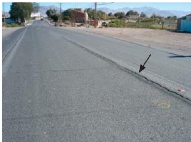
Figura 7-Trinca de retração
