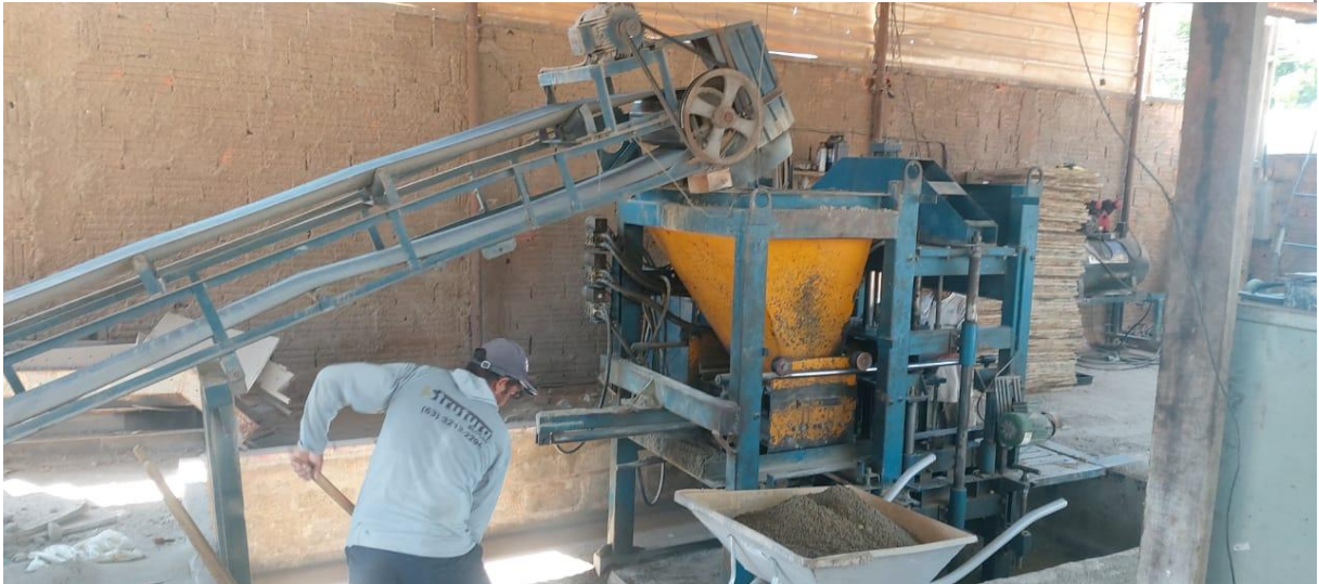
Figura 7 – Produção dos blocos de concreto na fábrica II.
