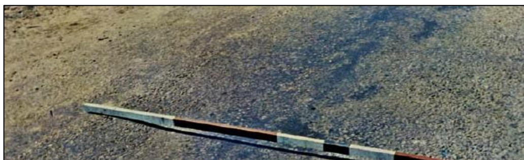
Figura 9 - Afundamento local
