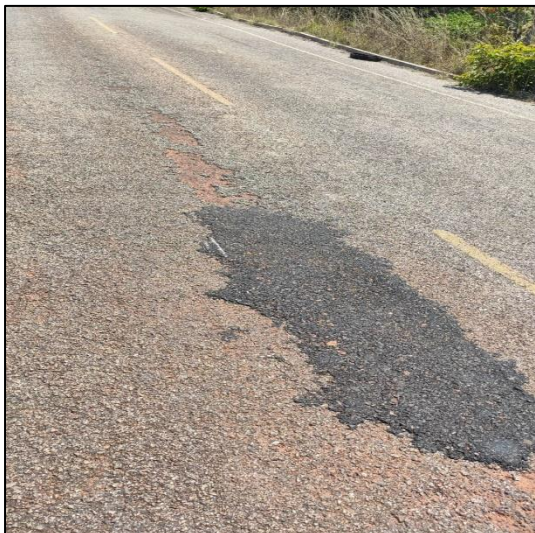
Figura 07 – Remendo e panela
