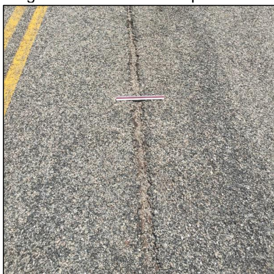
Figura 05 – Trinca longitudinal
