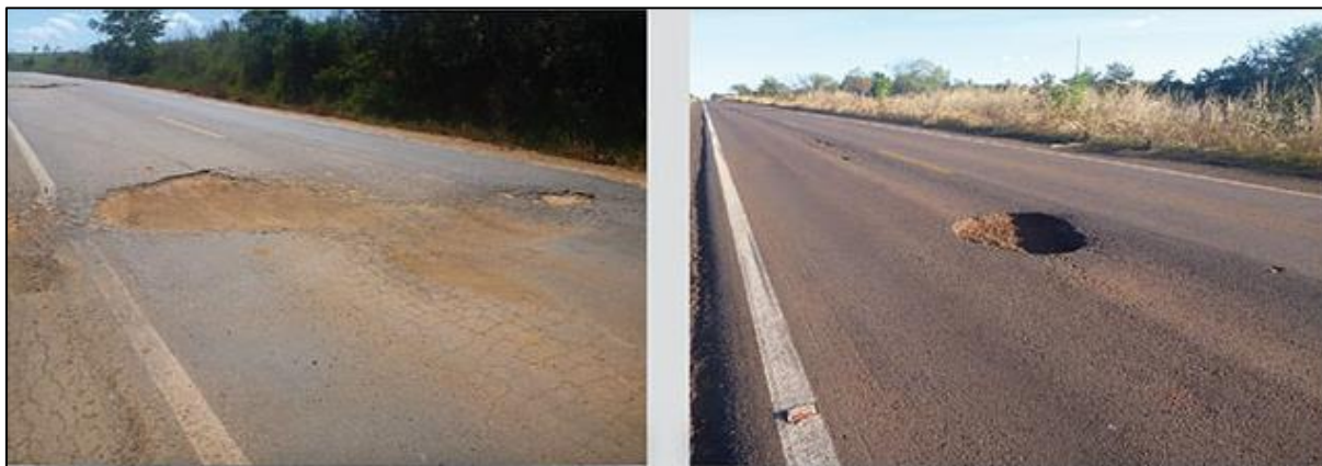
Figura 15 - Painela/buraco
