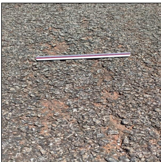
Figura 09 - Desgaste
