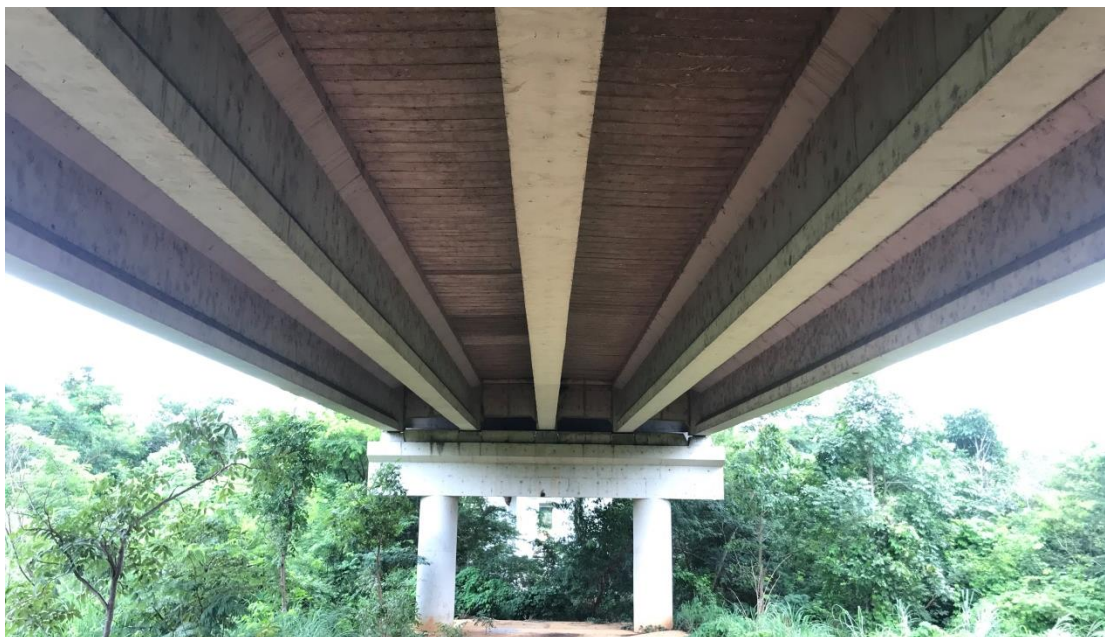
Figura 35: Vigamento Vão Lateral sentido Lajeado/Miracema (Fonte: Autor, 2020)
