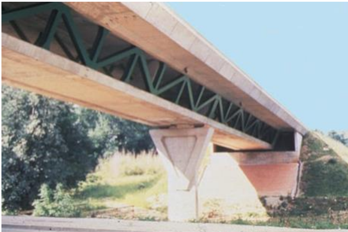
Figura 12: Ponte Arbois - França, 1985. (Fonte: https://structurae.net )
