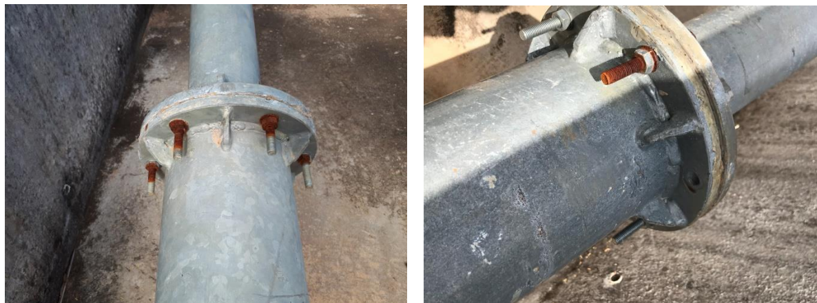
Figura 36: Flange dos Tubos Anti-Vandalismo dos Estais (Fonte: Autor, 2020)
