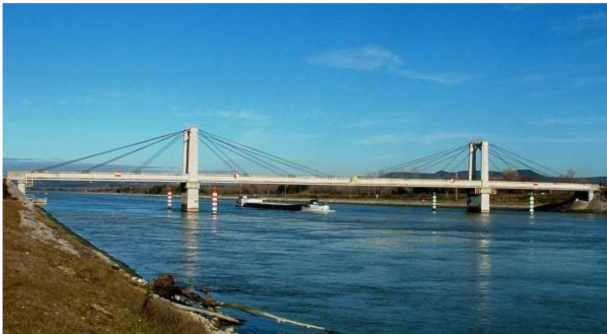
Figura 17: Ponte estaiada de concreto armado sobre o canal Donzère na França. (Fonte: Nicolas Janberg, www.structurae.net )
