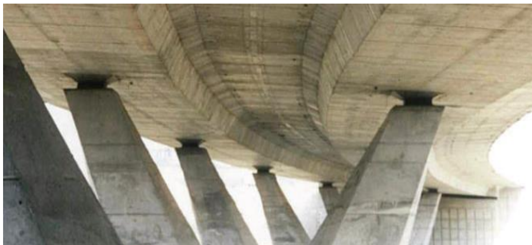
Figura 7: Aparelhos de apoio no topo dos pilares de uma OAE (Fonte: Quadros, 2013)
