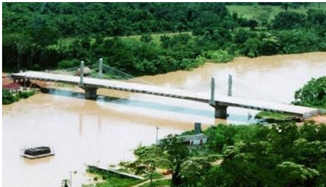
Figura 21: Terceira ponte sobre o Rio Acre – Brasil, 2006. (Fonte: Google Imagens)
