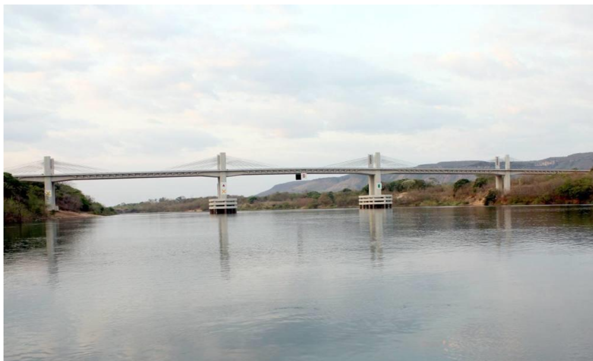
Figura 32: Vista Lateral Ponte dos Imigrantes Nordestinos (Fonte: Autor, 2020)
