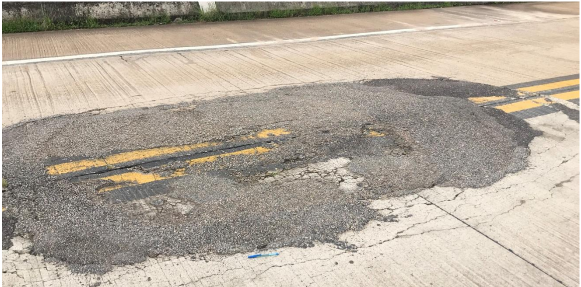
Figura 48: Reparo no Primeiro Vão da Ponte Sentido Miracema/Lajeado (Fonte: Autor, 2020)
