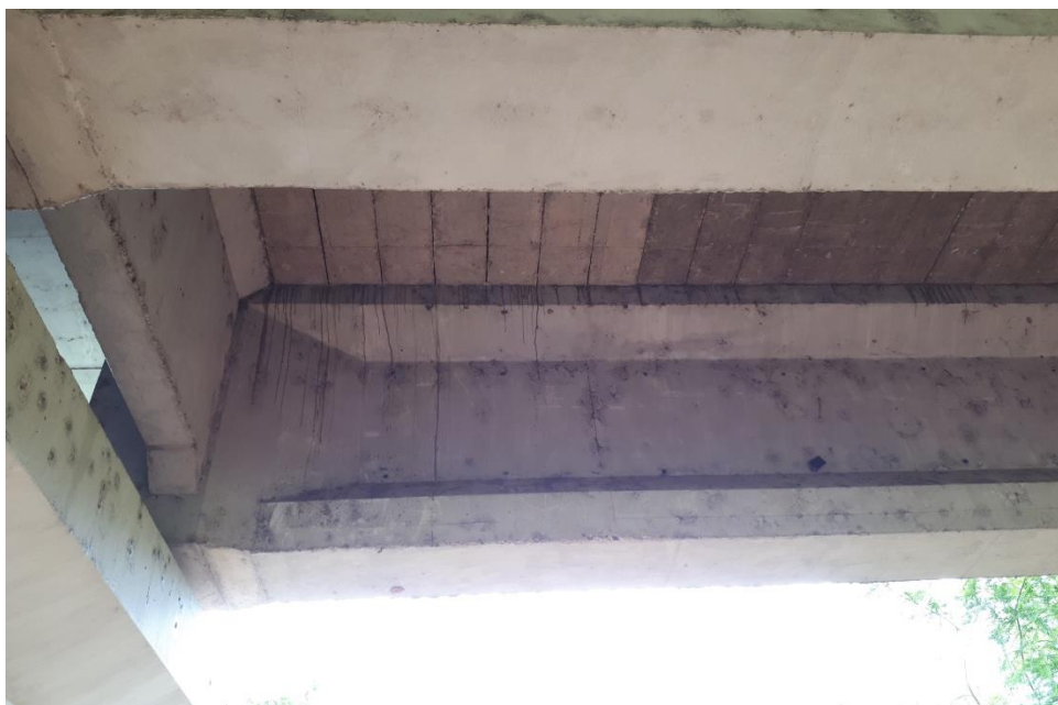
Figura 37: Encontro Viga Longarina e Transversa (Fonte: Autor, 2020)
