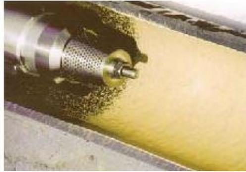
Figura 3 Método Spray lining
