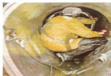
Figura 5 Instalação de elementos de revestimento de GRP numa rede de esgotos com condições de acesso de pessoa.
