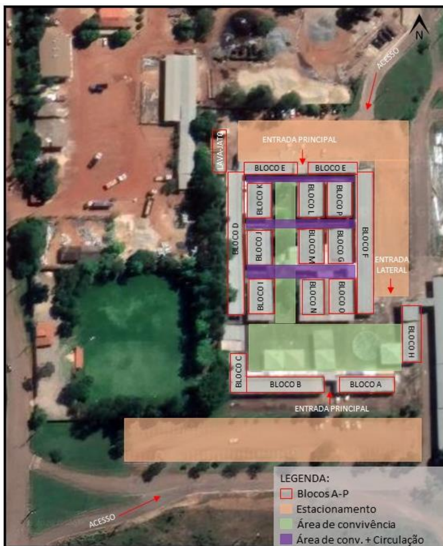
Figura 15 – Vista aérea do local
