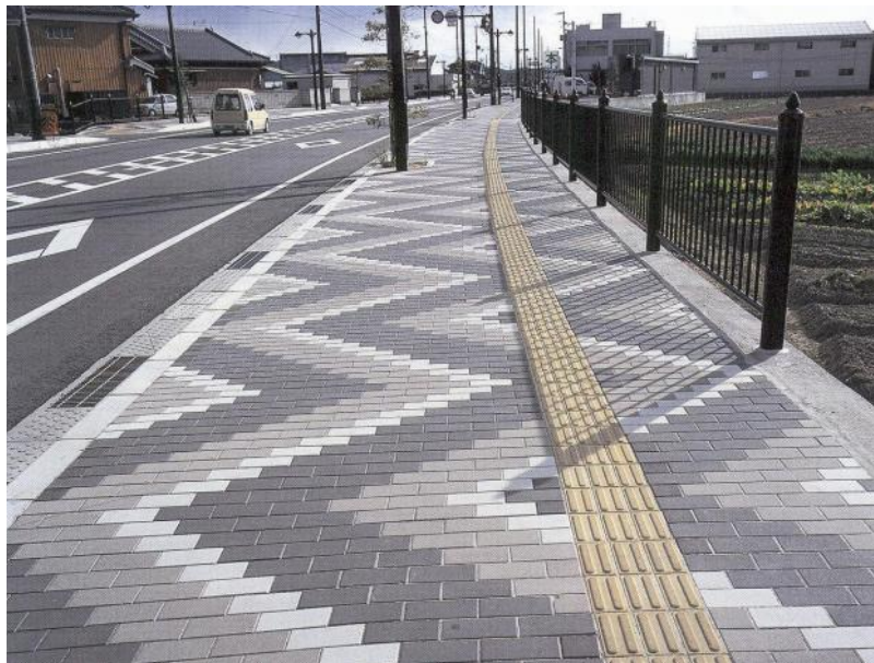
Fig. 04 – Calçada nivelada com piso tátil direcional e intertravado
