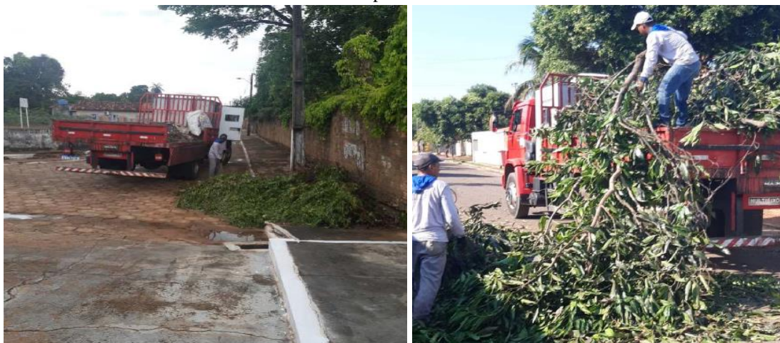
Foto 6 – Coleta e Transporte de Galhadas e Entulhos.
