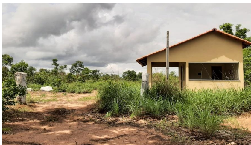
Foto 21 – Guarita do Aterro Sanitário de Pedro Afonso.
