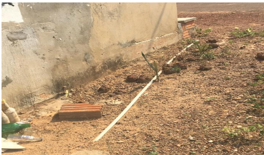
Foto 5 – Rede de abastecimento de água fria exposto
