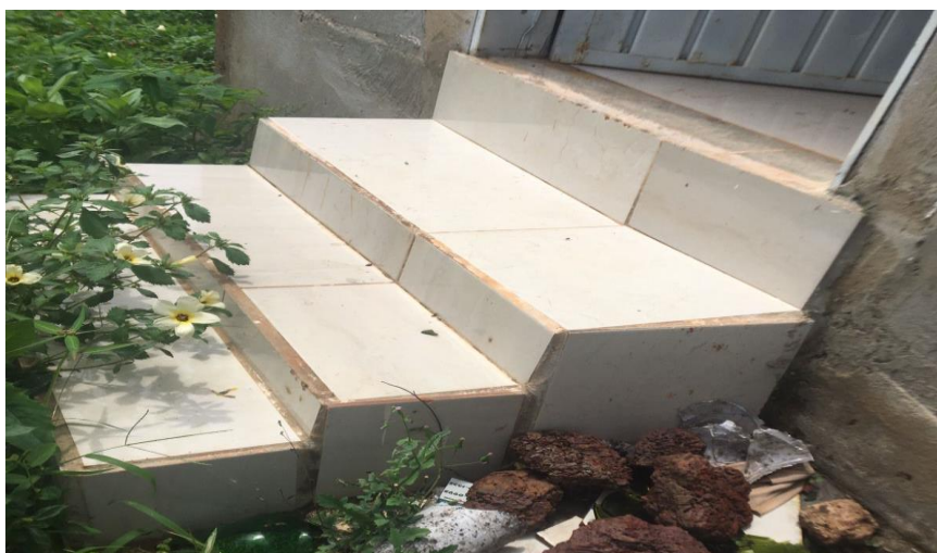
Foto 4 – Degraus de acesso a residência
