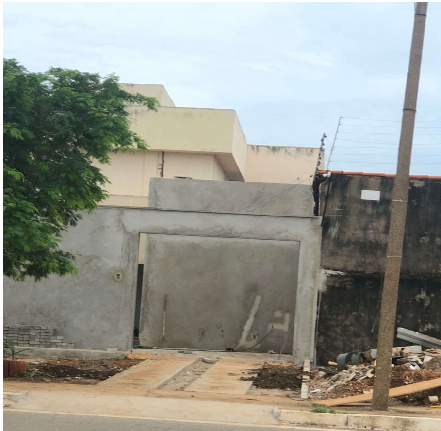
Figura 2: Obra – Panorâmica – Exemplo de obra n° 01
