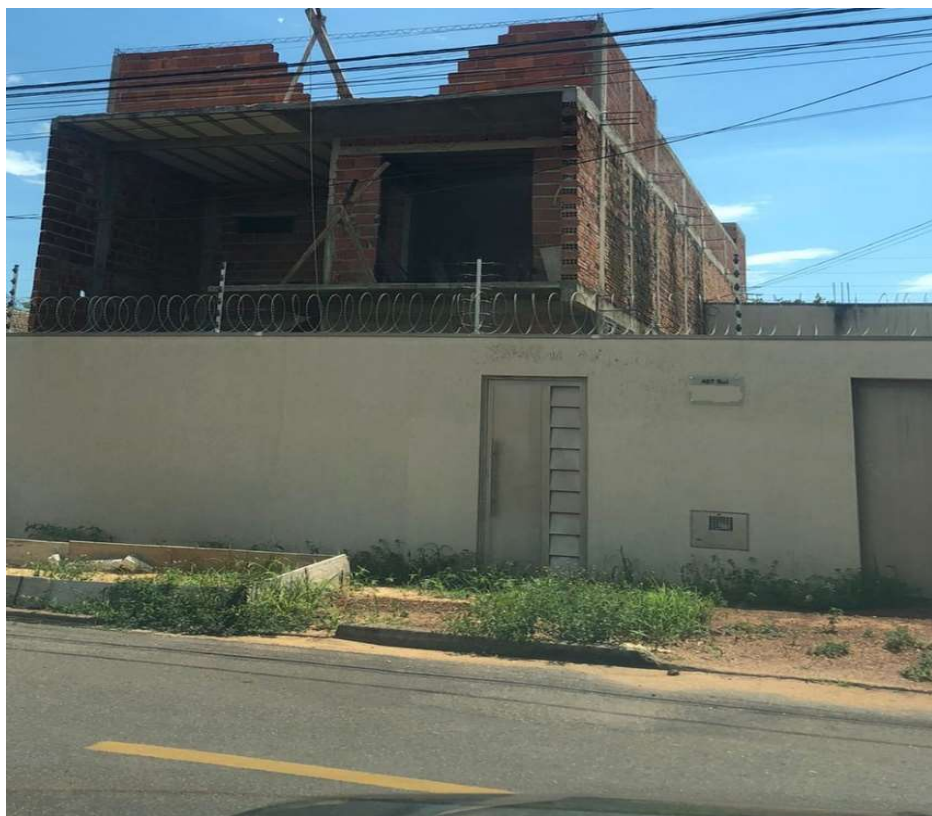
Figura 4: Obra – Panorâmica – Exemplo de obra n° 3
