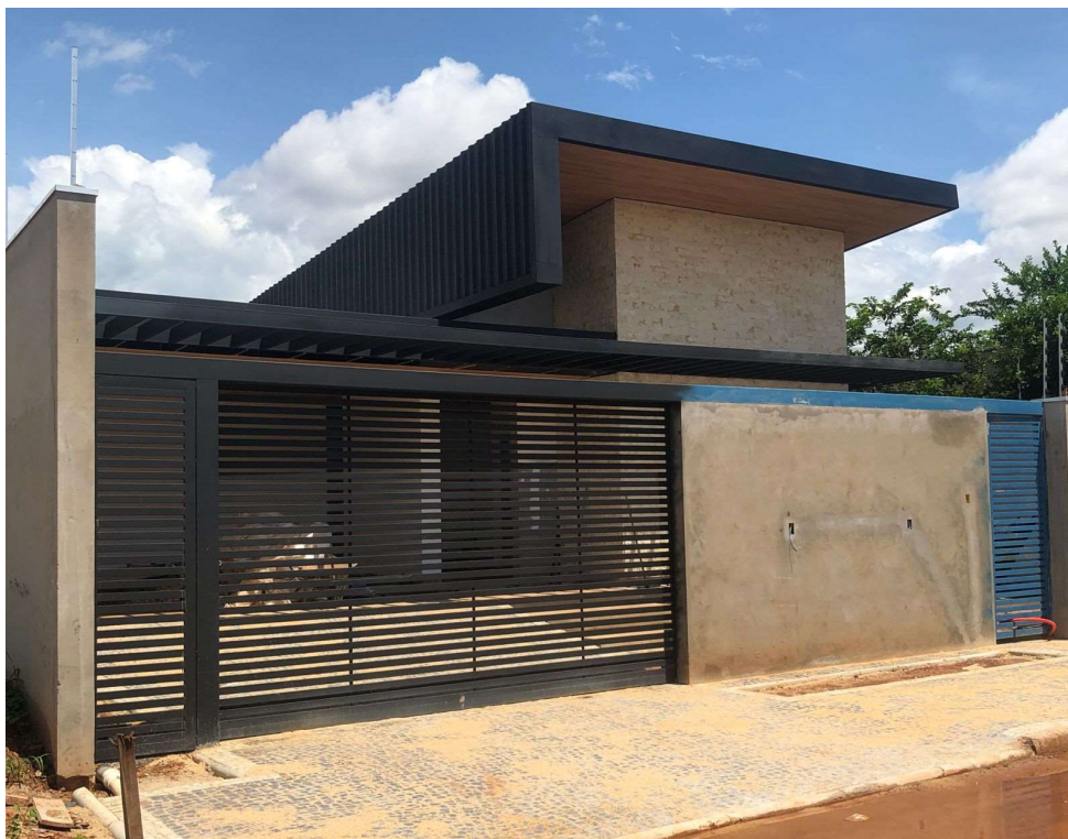
Figura 3: Obra – Panorâmica – Exemplo de obra n° 2
