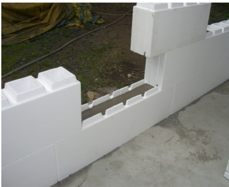
Figura 6. Concretagem das vedações
