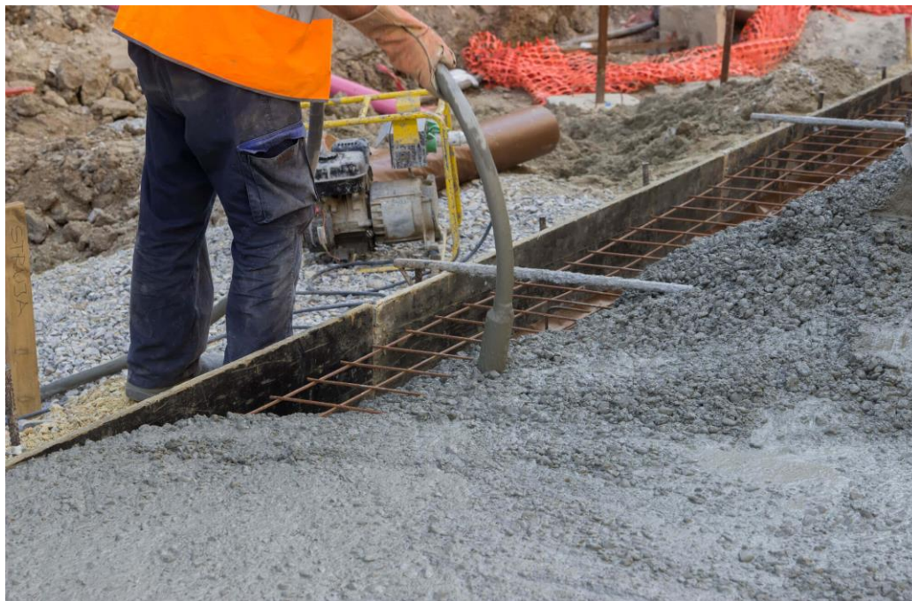
Figura 8: Trabalhabilidade do concreto.
