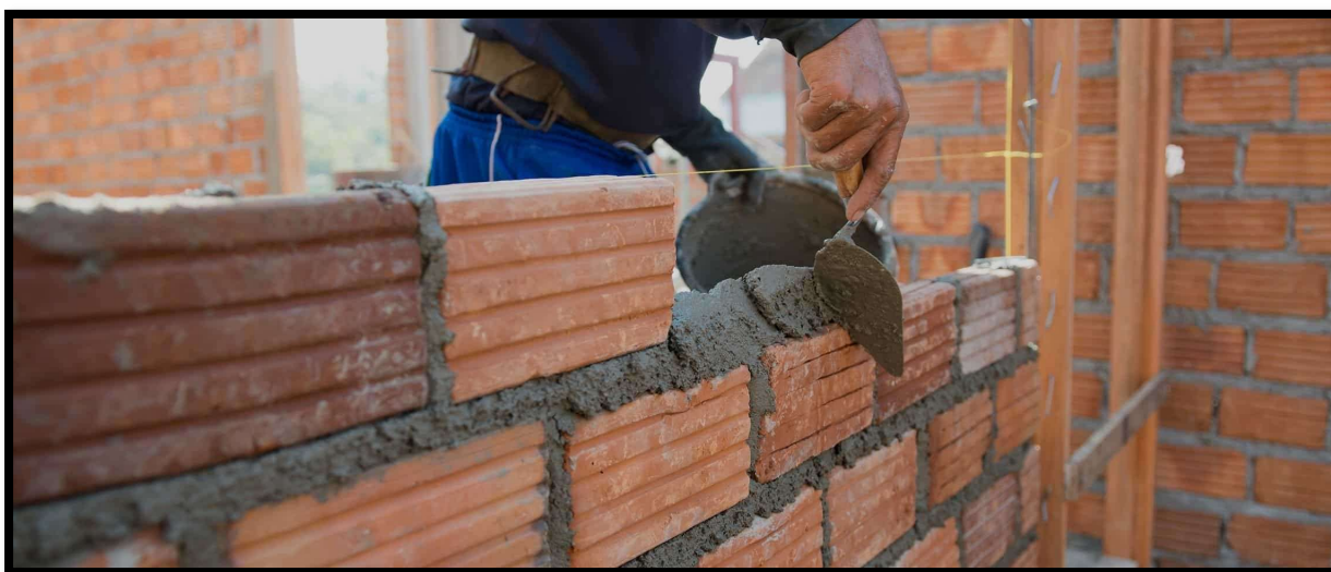
Figura 2 – Construção de parede com blocos cerâmicos
